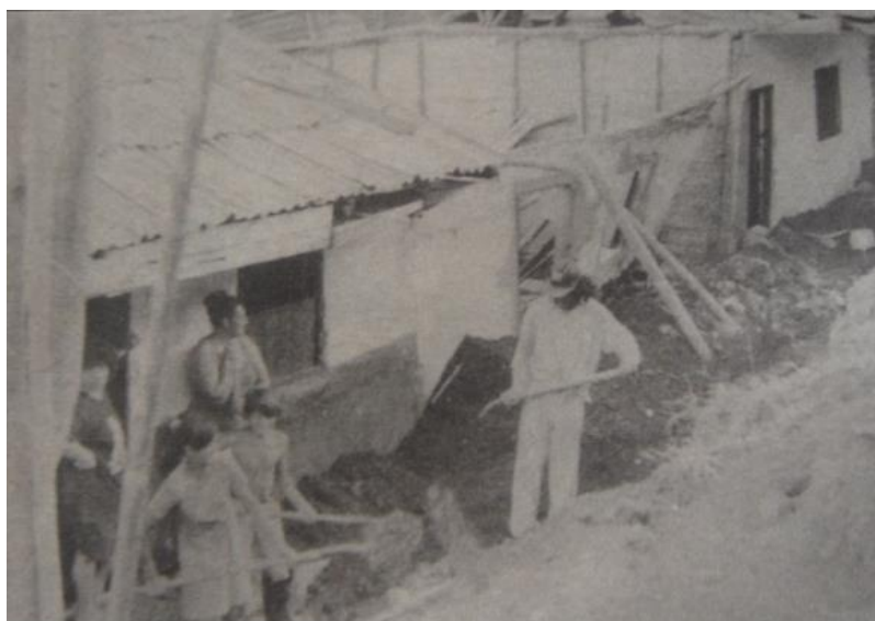
Fotografía 7. Deslizamiento del año 1992 en el área urbana del Municipio de Yumbo.
