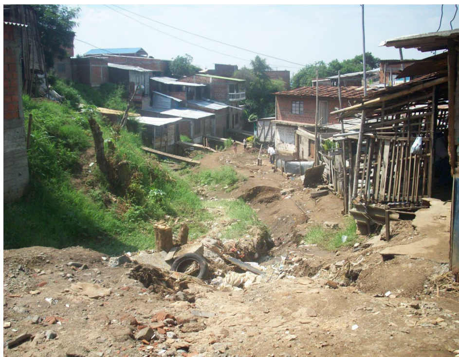
Fotografía 8. Deslizamiento del año 2010 Barrio Panorama – Parte Alta, Área urbana del Municipio de Yumbo.
