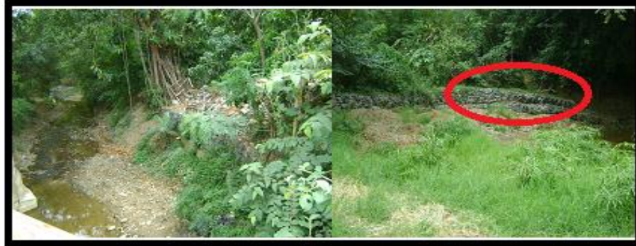
Foto 2: Jarillon Instalado sobre el rio Yotoco.
