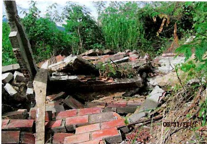
Escombros de vivienda afectada por el Deslizamiento rotacional que la destruye y transporta pendiente a bajo dentro de la masa de suelo.
