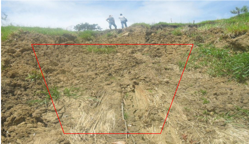
Esta fotografía es cerca al casco urbano del municipio donde se presentó un movimiento en masa de gran tamaño, debido a las fuertes lluvia.
