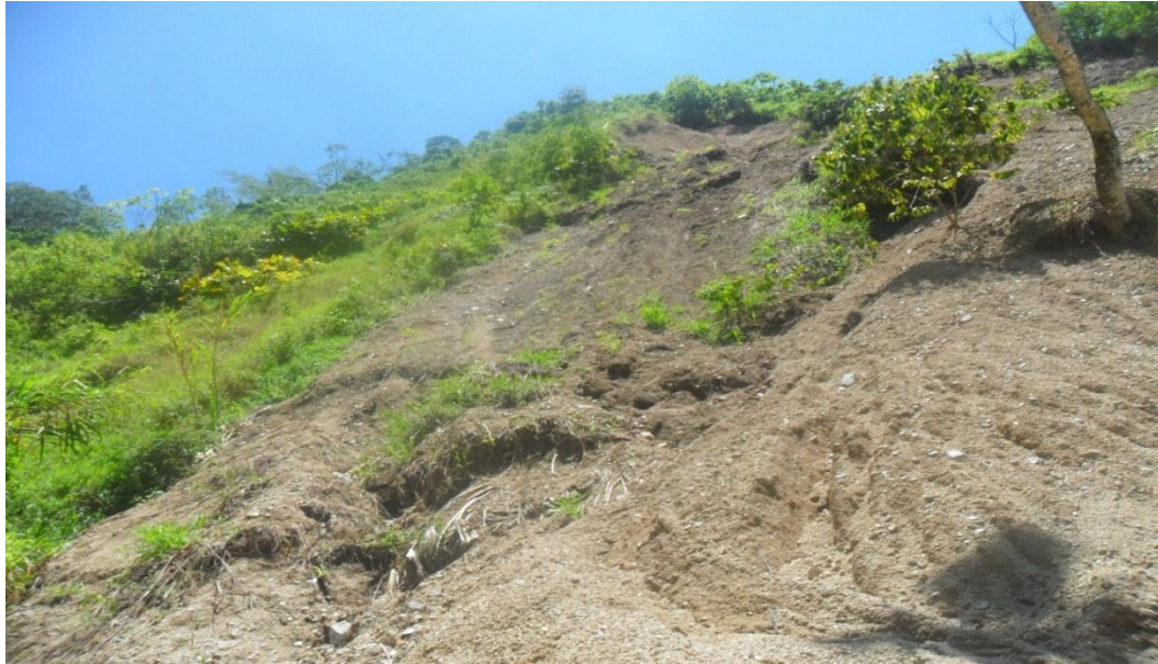
Remoción en masa ubicada en el corregimiento de san José del tarra.
