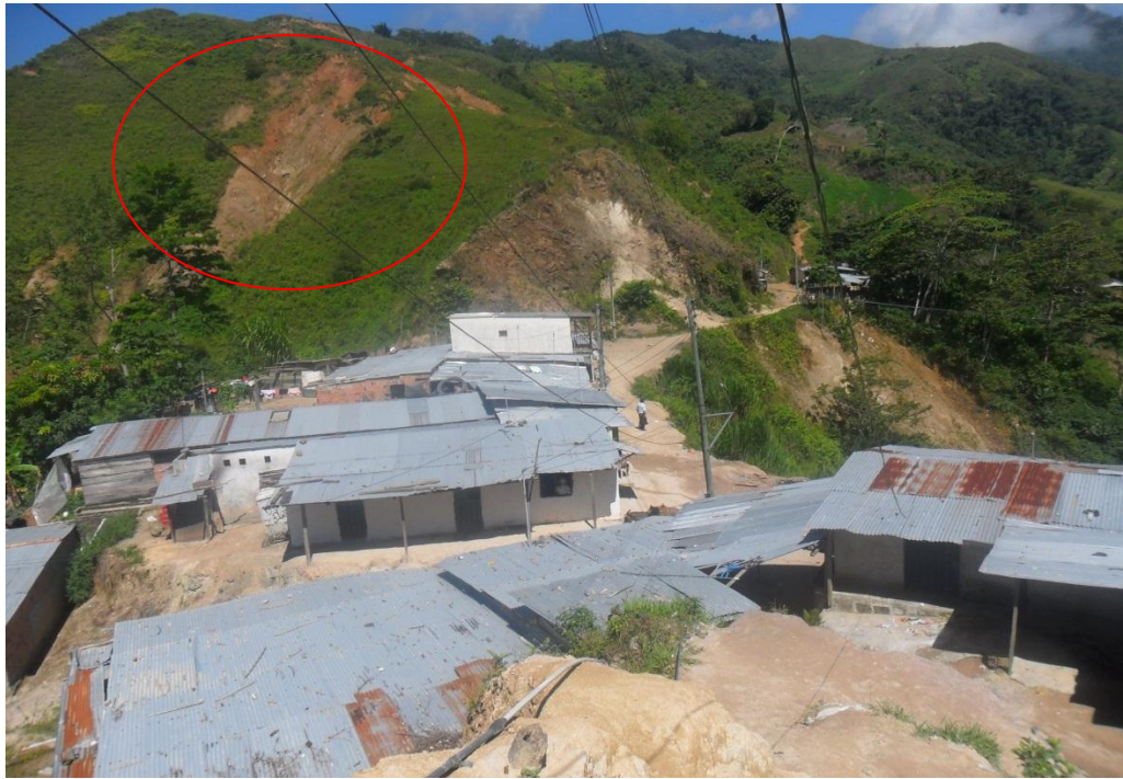
Panorámica del caserío la capilla donde podemos observar en la parte superior de la fotografía movimiento o remoción en masa, al lado izquierdo derrumbe o caída del talud en el cual estaban construidas 10 viviendas, las cuales fueron destruidas totalmente.
