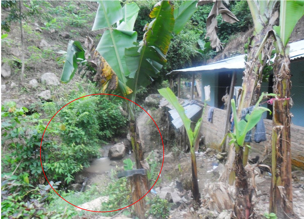
Este caño en época de invierno se desborda y causa problemas a las viviendas aledañas, en la parte baja del sector sub urbano de pinzón castilla.
