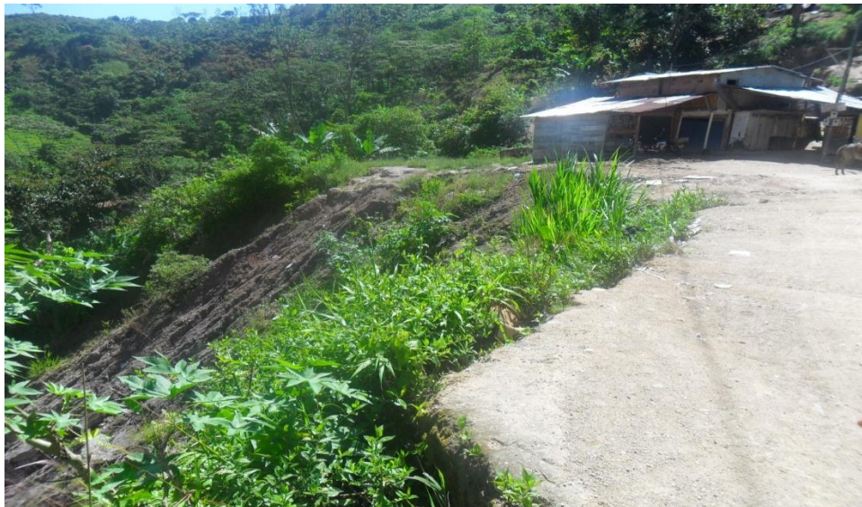
Centro poblado la capilla, pertenece al corregimiento de mesitas el cual se derrumbaron aproximadamente 10 casas por la ola invernal en el año 2011.
