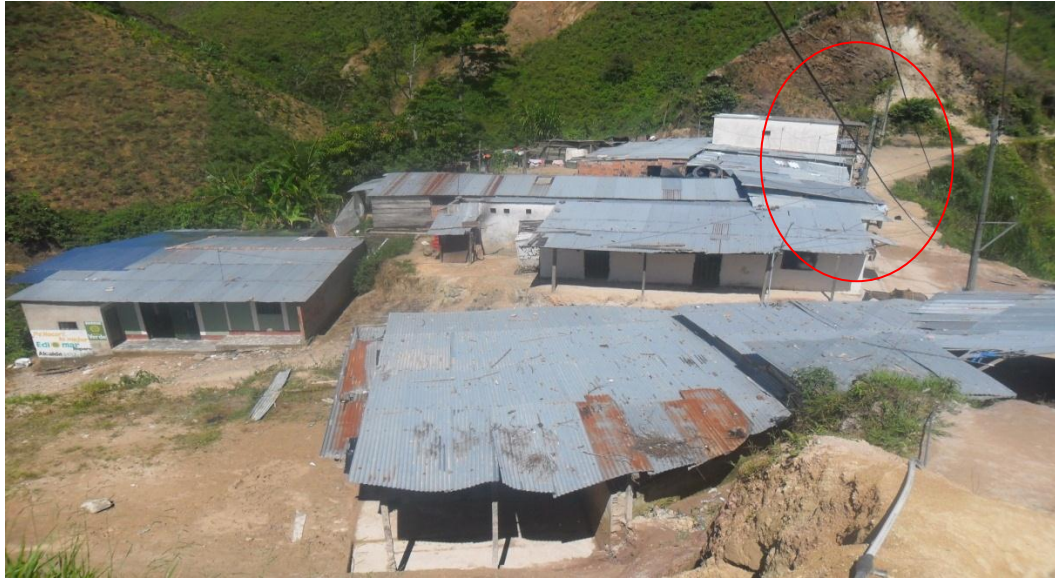
Afectación geológica del caserío la capilla
