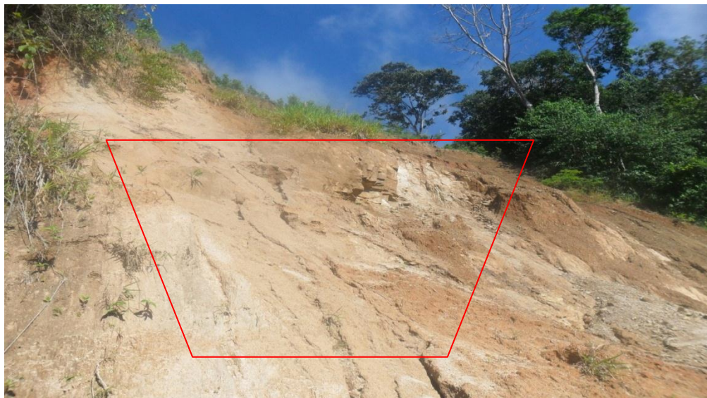
La erosión es otro factor de riesgo presente en el municipio de Hacarí.
