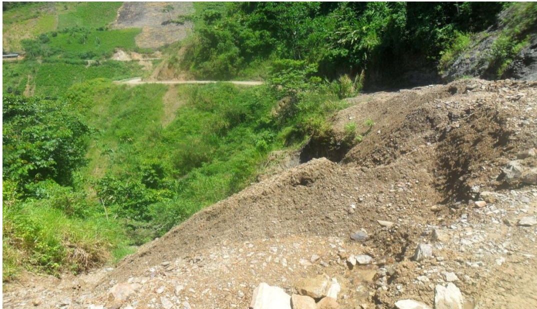
Material producto de remoción en masa en la vía al corregimiento de mesitas.
