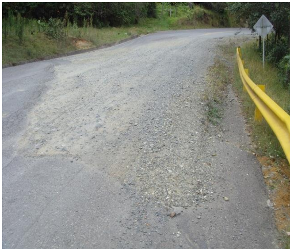
Figuras 43 y 44. Hundimiento de la banca vía Totoró-Popayán y Camino afectado por deslizamiento vereda alto Palacé. (Por: Harold R)
