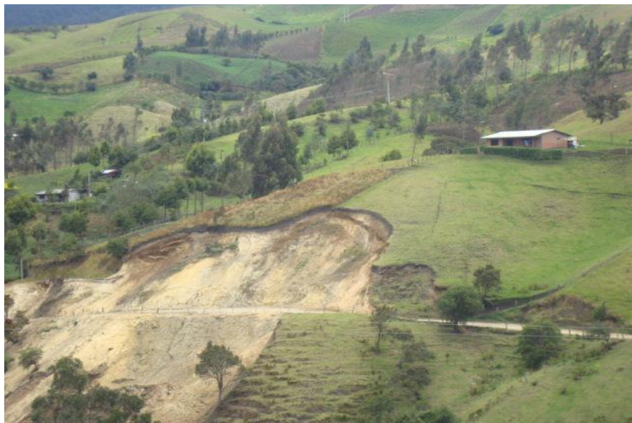
Figura 34. Vivienda en Riesgo de deslizamiento-Vereda Aguas Vivas. (Por: Fabián Belalcázar)
