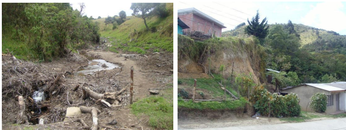
Figuras 39 y 40. Pequeño represamiento quebrada aguas claras y vivienda en riesgo, Municipio de Totoró. (Por: Harold R, Fabián B)
