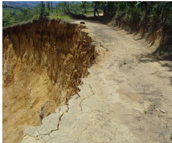
Figuras 43 y 44. Hundimiento de la banca vía Totoró-Popayán y Camino afectado por deslizamiento vereda alto Palacé. (Por: Harold R)
