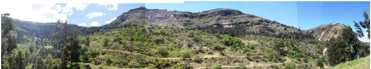
Deslizamiento de Peña de las Aguilas, Tópaga
