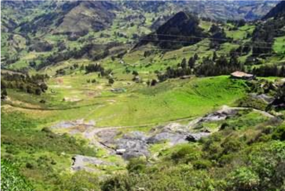
Deslizamiento vereda Atraviezas, sector El Rosal (K2+450, vía Tópaga – Mongua)
