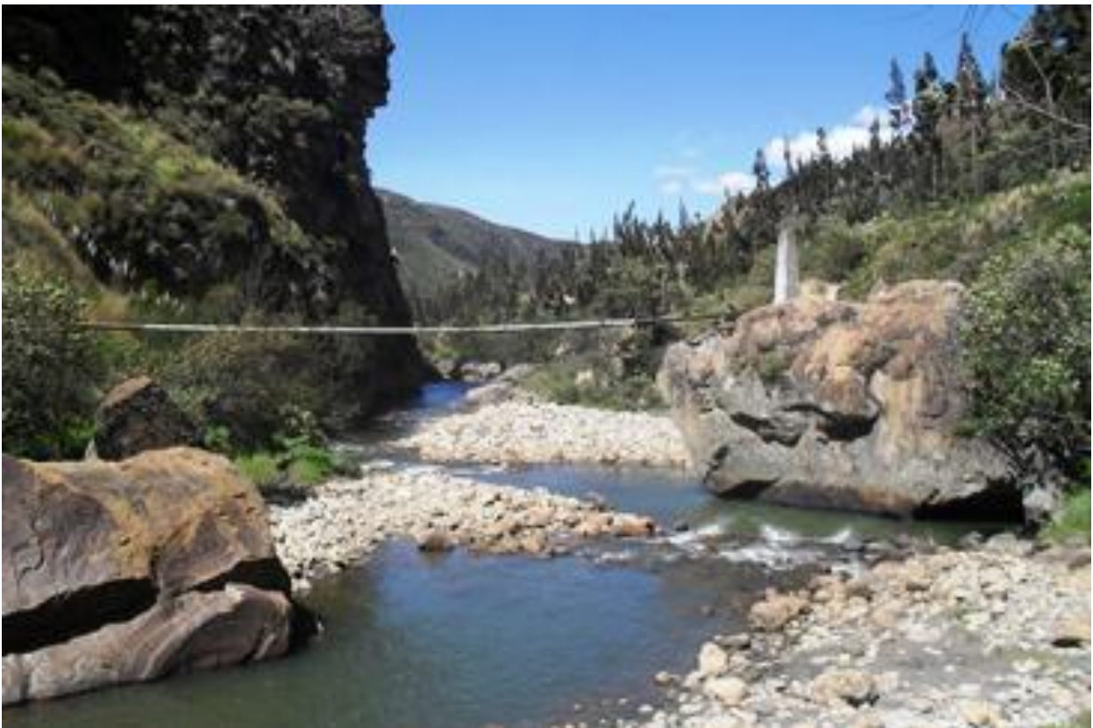
Río Gámeza (límite entre Tópaga y Gámeza), en Peña de las Aguilas (cruza tubería acueducto de Corrales)
