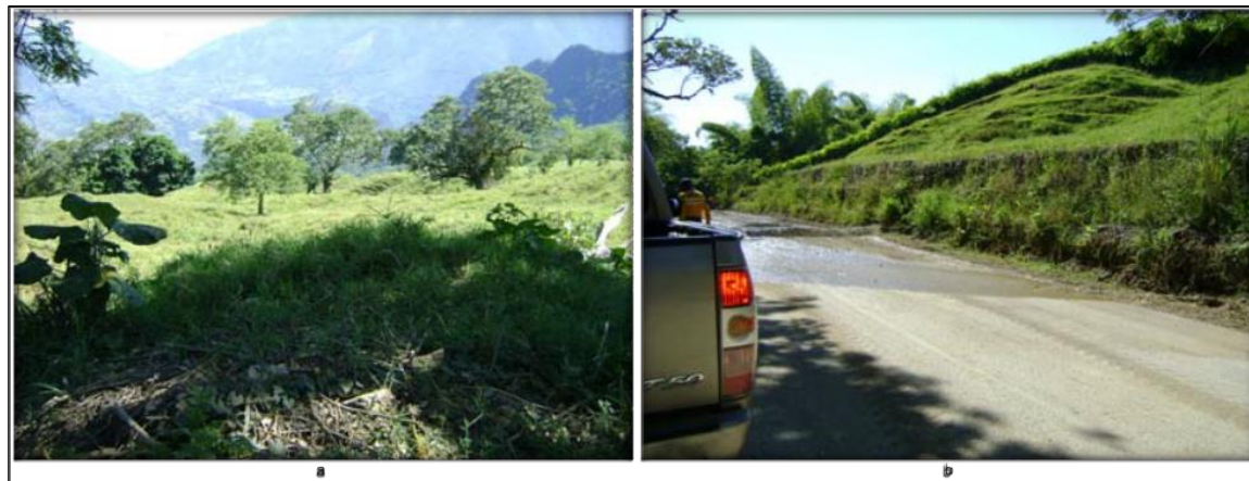
Fotografía 13 – Suelo en reptación y obras de contención (Quebrada La Sucia – Parte media de la cuenca).
