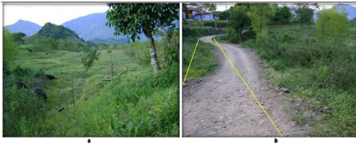
Fotografía 9 – Terreno en reptación y desplazamiento de la vía – Cerro Santa Catalina.
