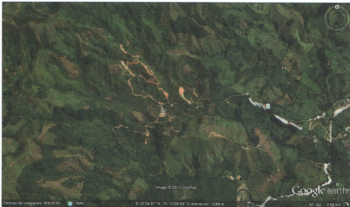
Erosión intensa sobre suelos en Vereda La Frisolera
