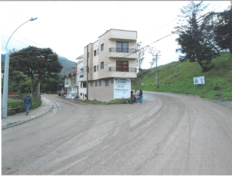
Sector Quebrada Arriba en amenaza por inundación
