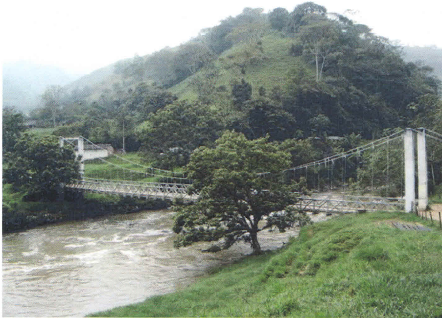
Puente colgante sobre el Rio Porce
