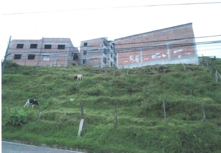
Construcciones nuevas en sector Campo Alegre, Sobre talud en amenaza alta por movimiento en masa
