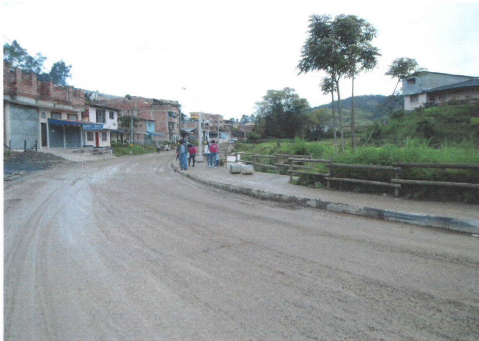
Calle 28 de acceso al municipio, luego de inundada
