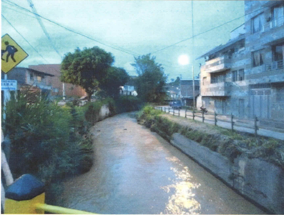
Quebrada Donmatias a su paso por el casco urbano. Su sección hidráulica es insuficiente para conducir los caudales en periodos de invierno
