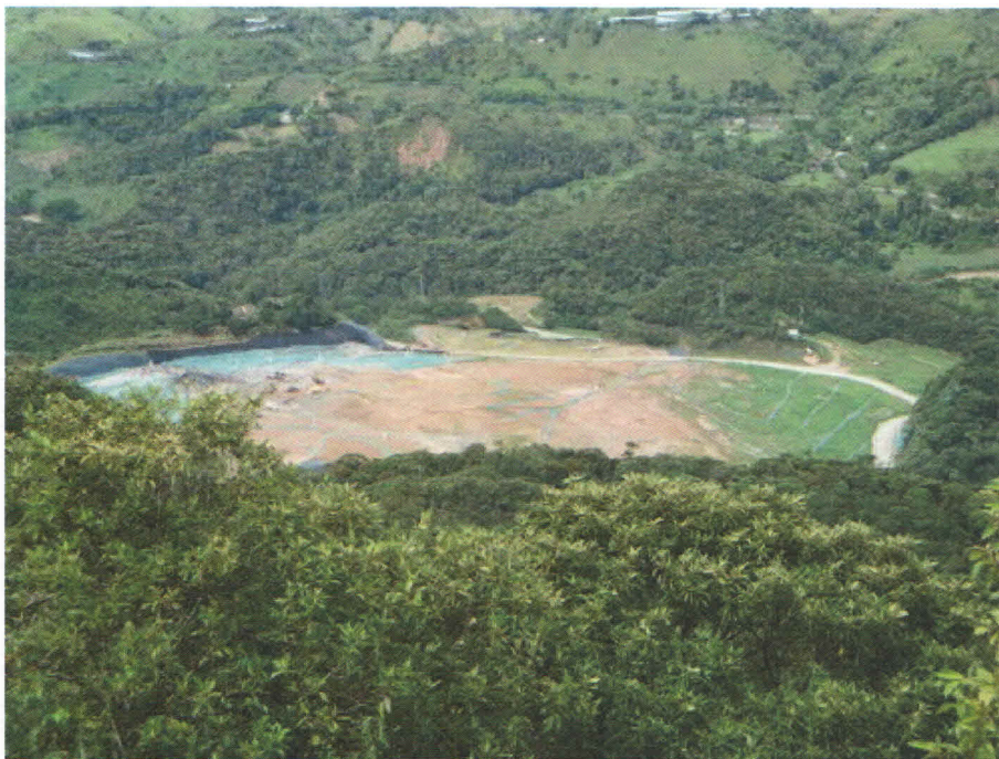
Relleno sanitario Pradera
