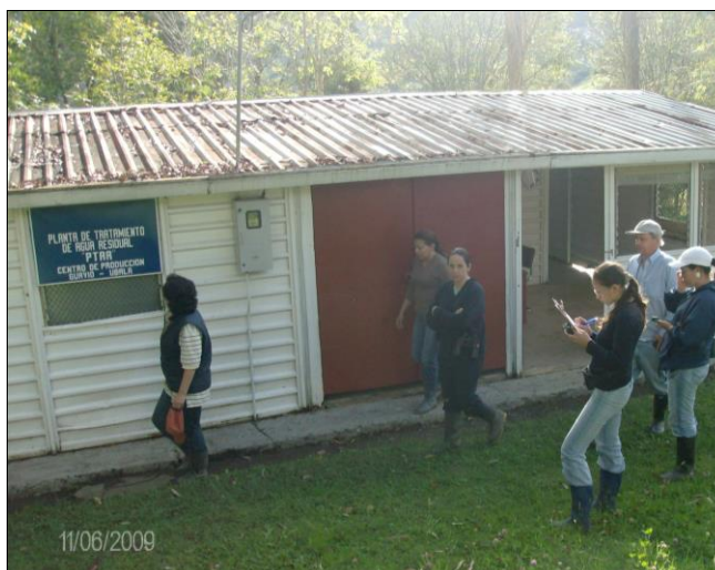
Foto 44. Instalaciones de la planta de tratamiento de agua residual EMGESA.
