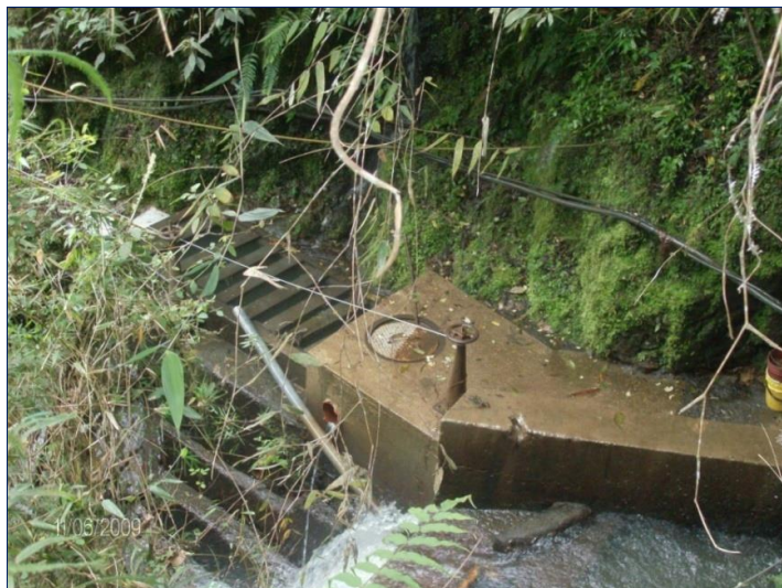
Foto 41. Planeación Ecológica Ltda. -Bocatoma del acueducto de EMGESA S.A.
