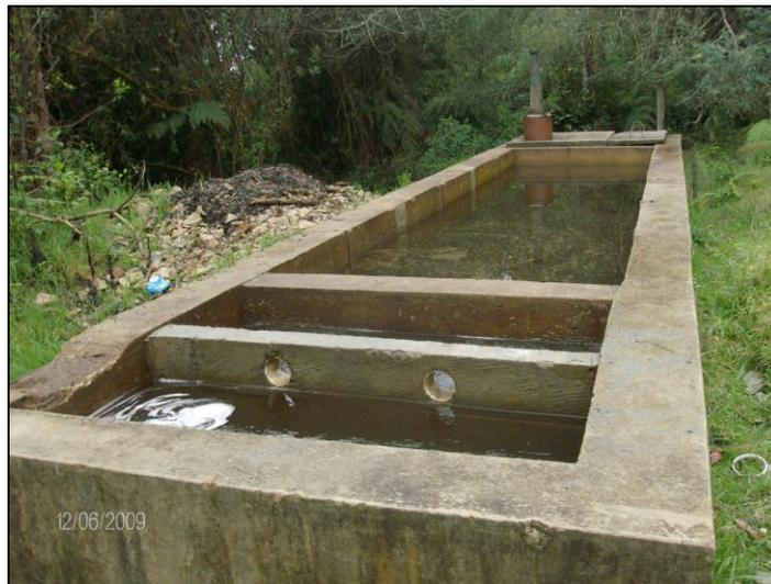
**Foto 42. Tanque desarenador del sistema de captación de la quebrada Chinagocha.**
