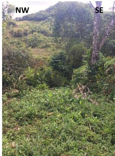
Fotografía 34. Laderas de la Formación Caja, que confinan el cauce del caño El Humilladero; las orillas son de poca altura y el gradiente hidráulico es muy bajo. Coordenadas: 4° 38'42'' N, 73°19'20'' O, h 770 m. Fuente: PI Planificación Integral Consultores S.A.S, 2017.
