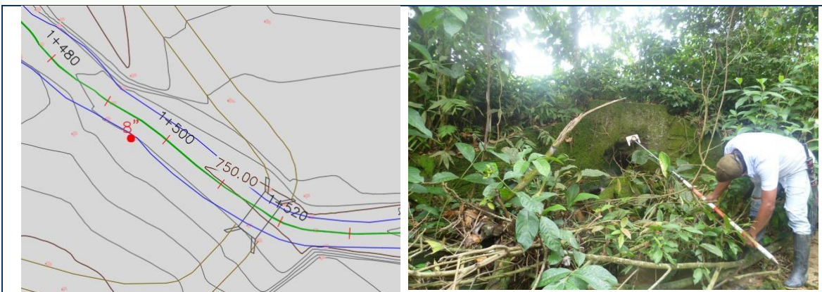
Figura 15. Vertimiento en la quebrada Gazajujo sector k1+500
