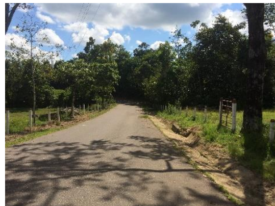
Fotografía 43. Vía principal de acceso.
