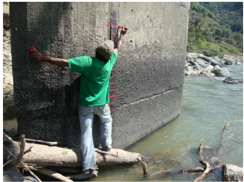
Fotos 4 Voluntario realizando actividades de instalación de instrumentos de monitoreo en zonas de acceso limitado en orilla de río. Fuente: Construcción propia
