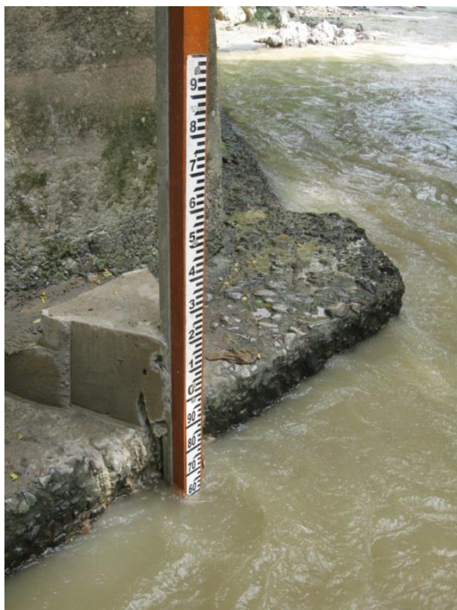
Figura 11 Escala hidrométrica sujeta a estructuras fijas
