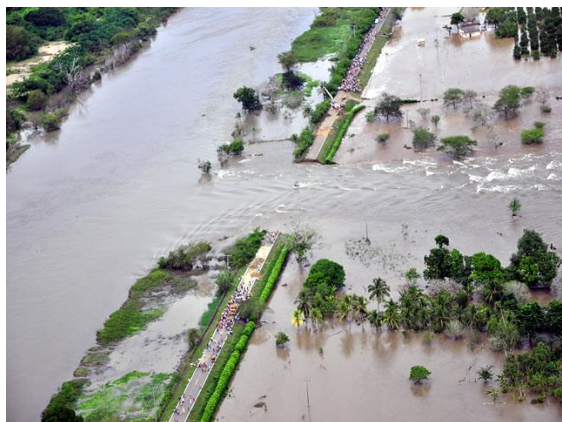
Figura 4. Rompimiento jarillón Canal del Dique, 2010. Fuente: www.emisoraatlantico.com.co
