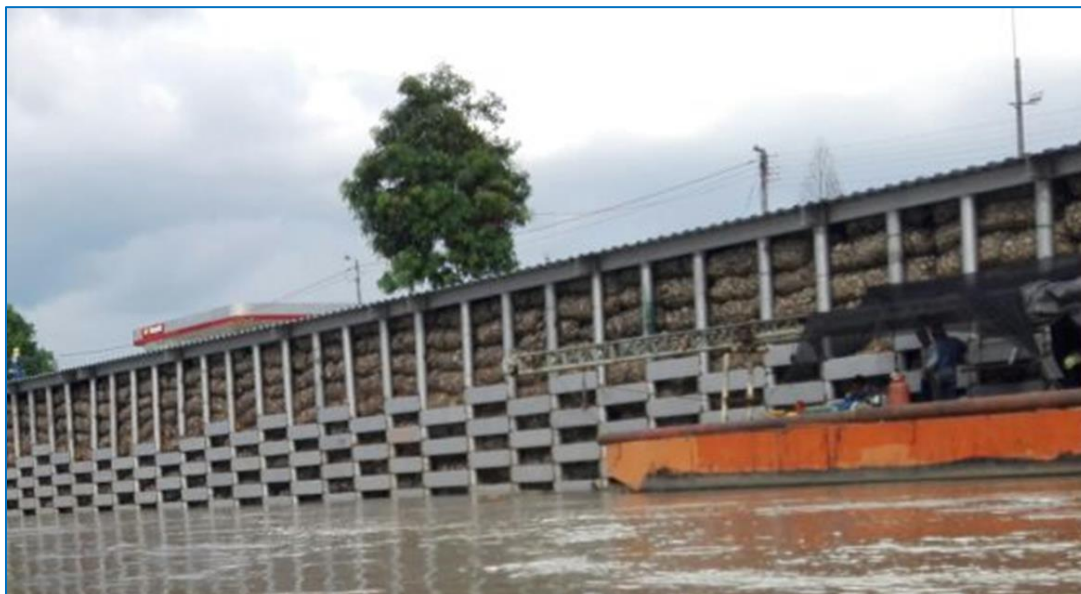
Figura 29. Obras para la protección de la orilla del Rio Arauca; Municipio de Arauquita 2017 Fuente: UNGRD, 2017
