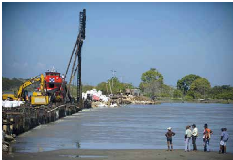
Las obras para reparar el Canal del Dique en una lucha contra la fuerza del agua que se hacía incontrolable. Aquí a la altura de Calamar, Bolívar, el 13 de enero de 2011.
