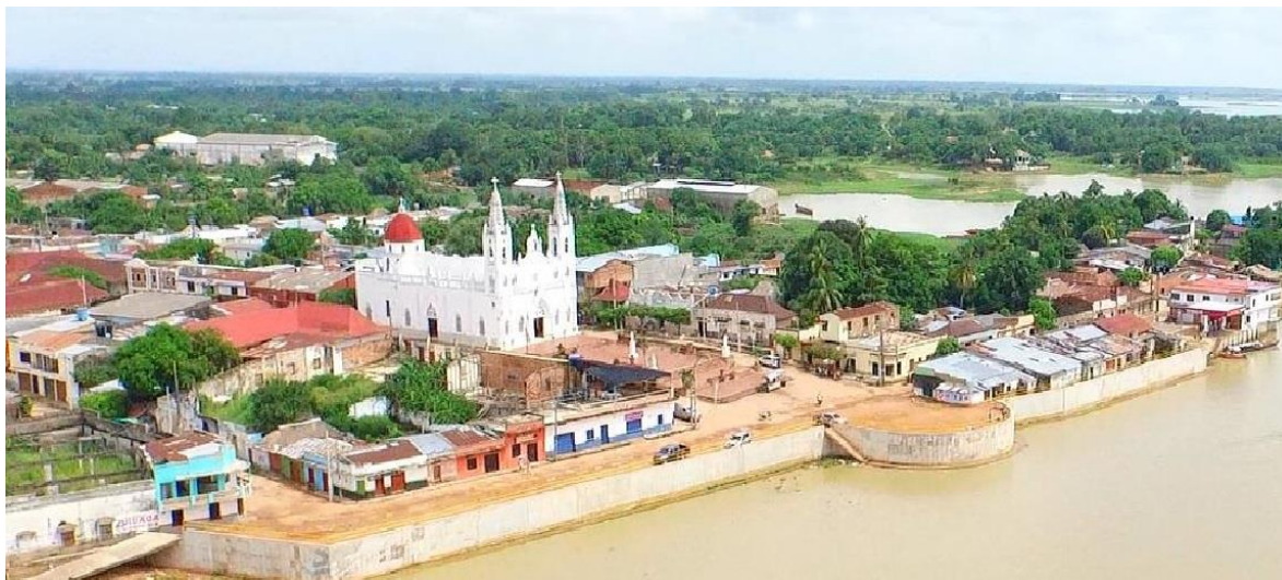
Construcción del muro de contención para la mitigación, prevención y control de inundaciones carrera primera en el casco urbano del municipio de Ayapel
