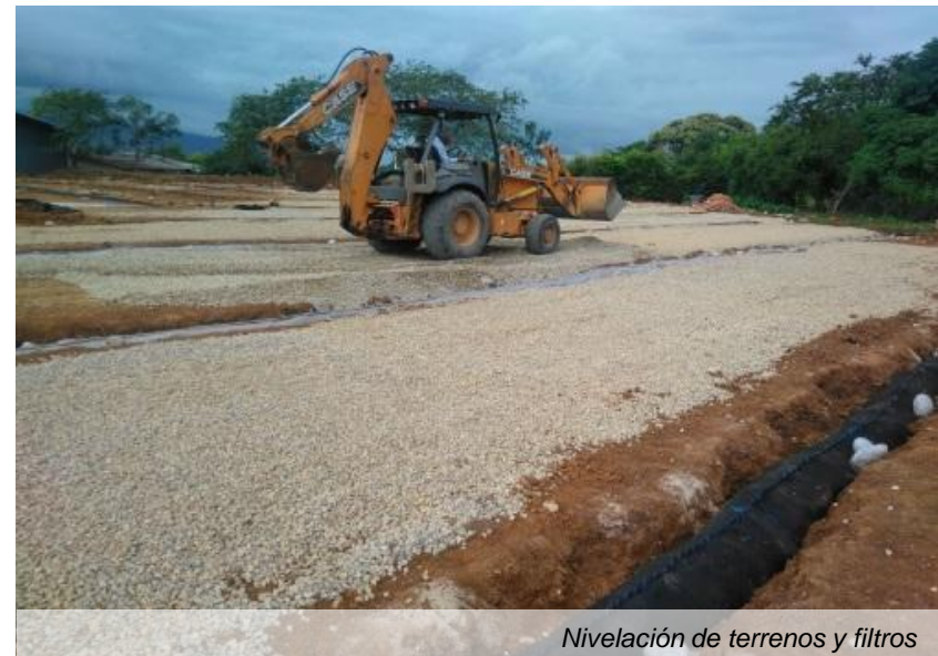
Excavación Filtros Sistema de Drenaje
