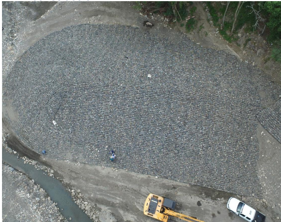
Ejecución obras de emergencia. Capitanejo Santander.
