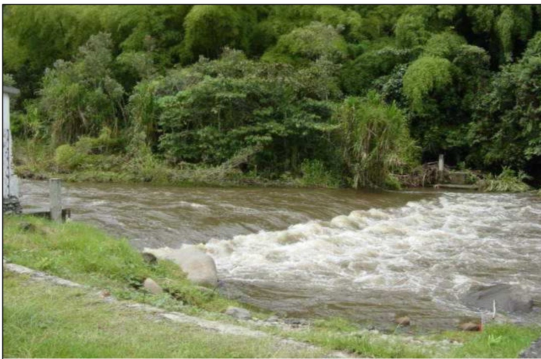
Fotografía 8: Bocatoma sobre el río Quindío (Equipo Operativo)
