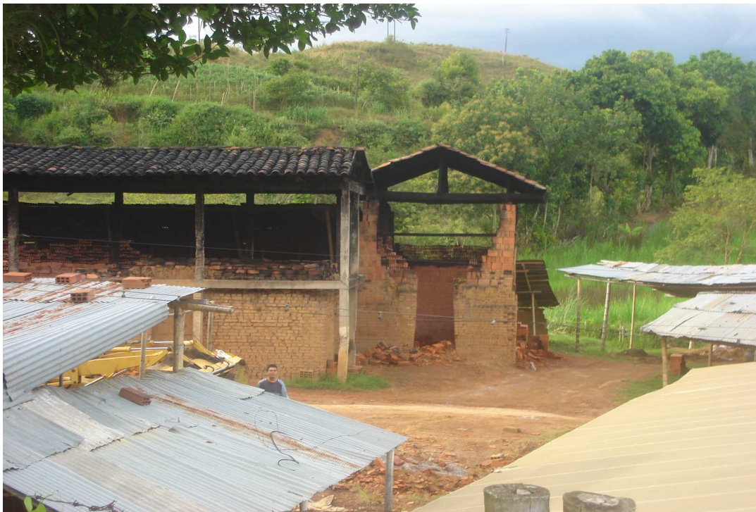
Fotografía 27: Ladrillera en el municipio de Caicedonia (Equipo Operativo)
