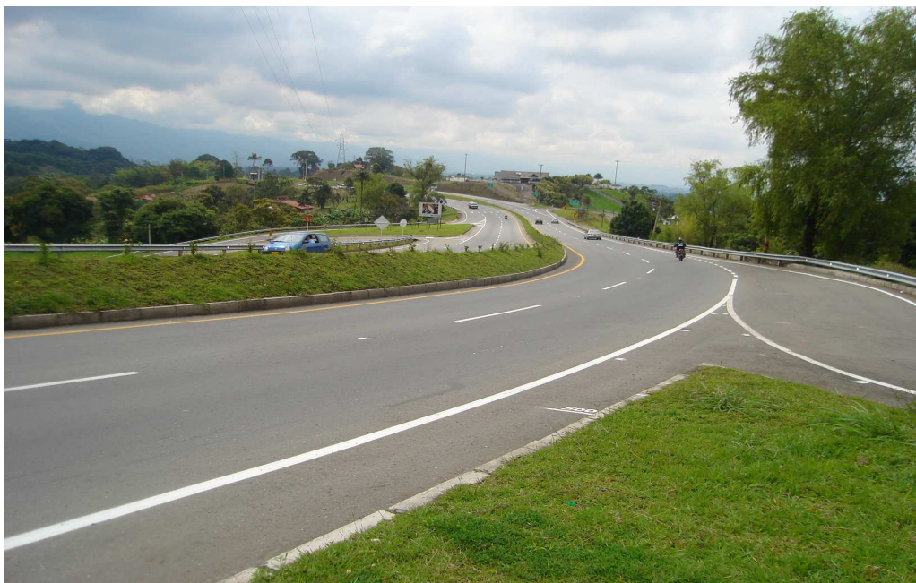
Fotografía 30: Infraestructura vial: doble calzada Armenia - Pereira (Equipo Operativo)
