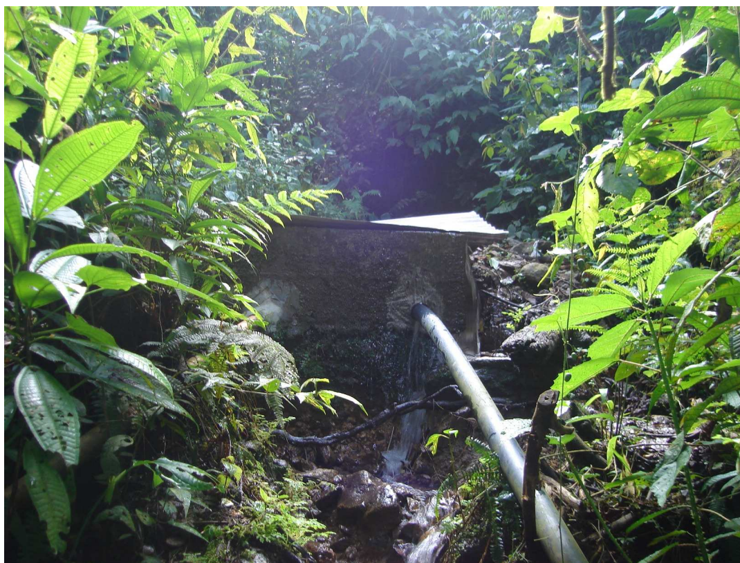
Fotografía 17: Bocatoma acueducto rural (Diego Duque)
