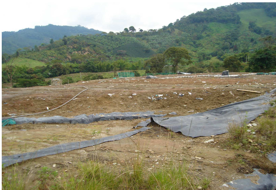
Fotografía 18: Relleno Sanitario Villa Karina (Calarcá), zona en operación (Equipo Operativo)
