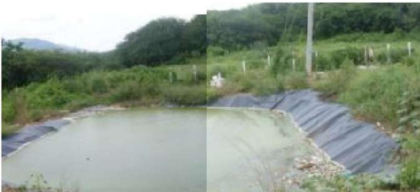
Figura 162. Laguna para manejo de lixiviados – Relleno Sanitario Municipio de Albania
