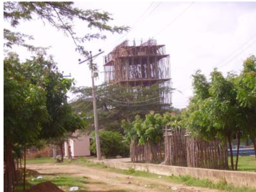
FIGURA 2.16. Tanque elevado en construcción, Corregimiento Paraguachón
