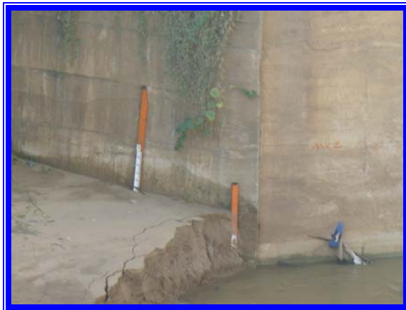
FIGURA 4.8 Estación Paraguachón (LM) – río Carraipía
