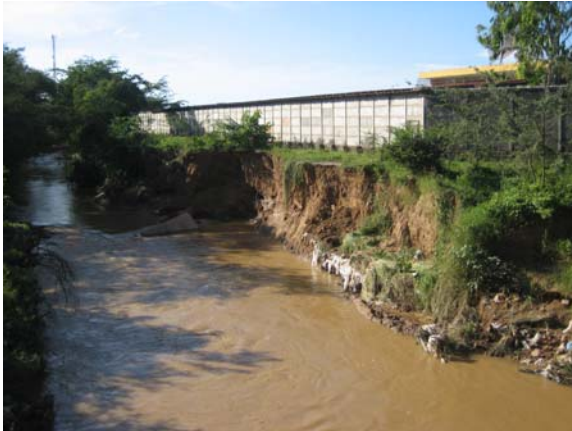
FIGURA 5.7 Proceso de socavación lateral por acción de la dinámica fluvial.
