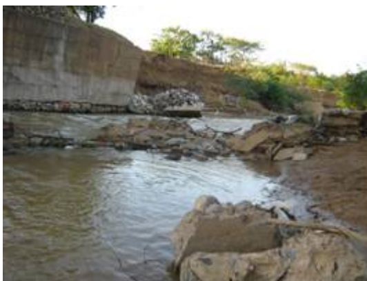
FIGURA 7.45 Parte baja de la cuenca Carraipía-Paraguachón, se aprecia la inadecuada disposición de residuos sólidos sobre el cauce del río.
