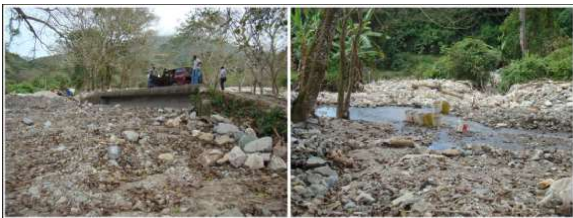
Fotografía 2.1.21. Vallecito aluvial colmatado por flujo de escombros.
