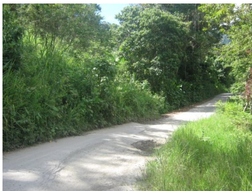
Fotografía 32. AMENAZA ALTA POR SISMICIDAD
