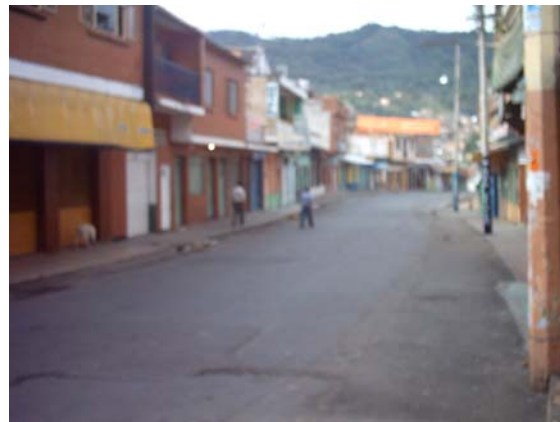
Mesitas del Colegio: Viviendas que no cuentan con elementos sismo – resistentes adecuados.
