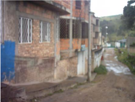
Villapinzón. Elementos estructurales que minimizan los daños durante un sismo.
