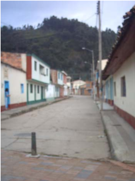
Nemocón. Viviendas que no cuentan con elementos sismo – resistentes adecuados.
