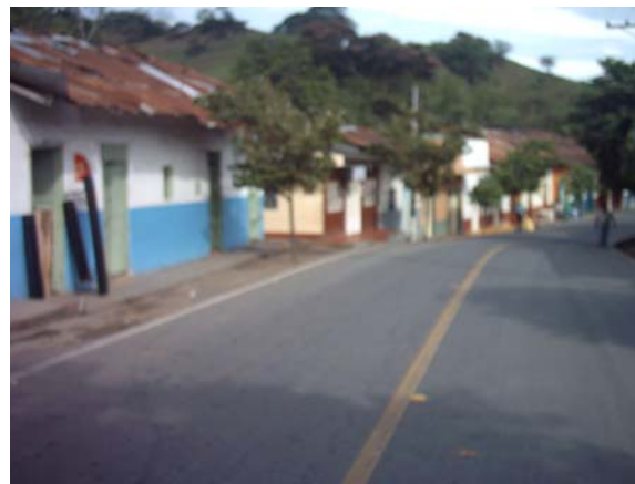
Mesitas del Colegio, a pesar de la diferencia de clima, su similitud con la vivienda de Nemocón es indudable, además de su baja resistencia ante un sismo.
