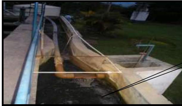
Figura 171 Canaleta Parshall. Planta de Tratamiento Acueducto Garzón
