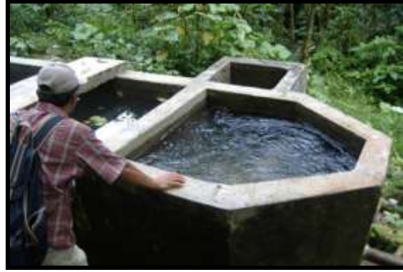
Figura 135 Detalle de vertedero de excesos en el Tanque desarenador.
