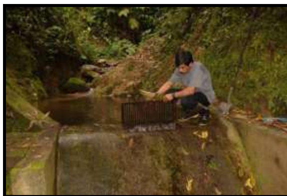
Figura 140 Mantenimiento de rejilla de la Bocatoma de Fondo
