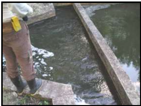
Figura 165 Detalle de vertedero de excesos, Tanque Sedimentador Acueducto Garzón
