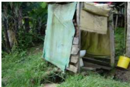
Figura 179 Manejo de Aguas Residuales Domésticas
