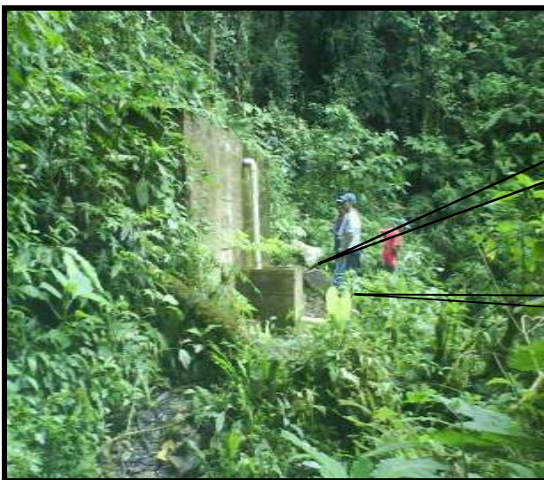
Figura 154 Tanque desarenador invadido por vegetación.
