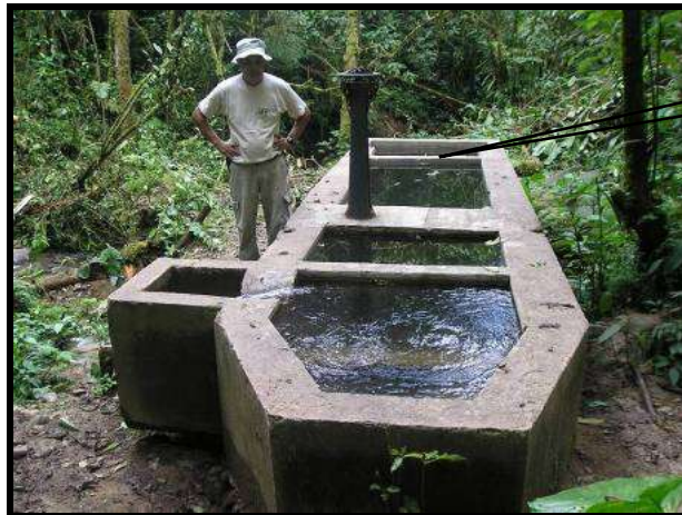
Figura 126 Detalle de elementos componentes del Desarenador Quebrada San Benito
