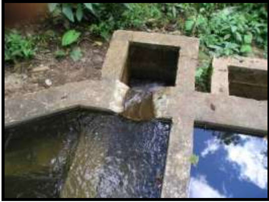
Figura 127 Vertedero de excesos en el desarenador Quebrada San Benito
