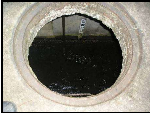
Figura 163 Cámara de aducción de la bocatoma del Acueducto Garzón
