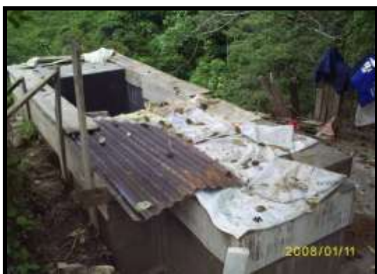
Figura 147 Tanque sedimentador en construcción
