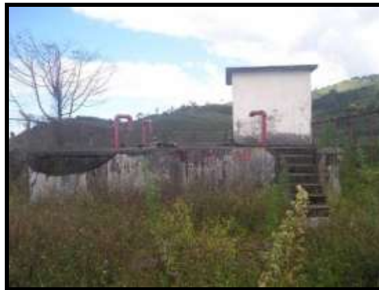
Figura 121 Tanque de almacenamiento que alimenta las veredas El Mesón, San Rafael y Claros
