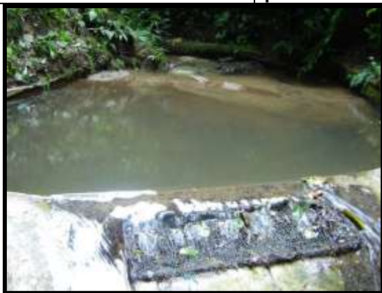
Figura 158 Bocatoma tipo fondo acueducto Filo de los Loros
