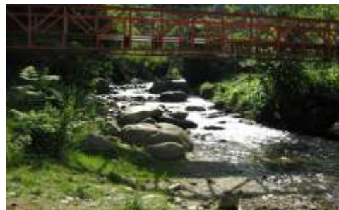
Figura 2 Estación 1 quebrada Garzón, en puente peatonal vereda La Cañada
