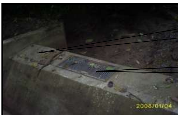
Figura 146 Detalle de Bocatoma de fondo recién construida
