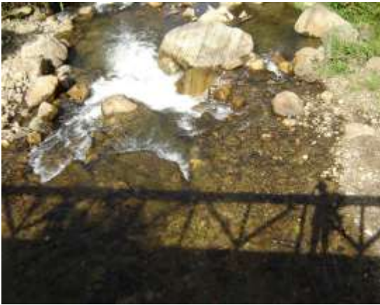
Figura 33 quebrada Garzón. Estación E1. Puente Peatonal La Cañada. Vista Superior
