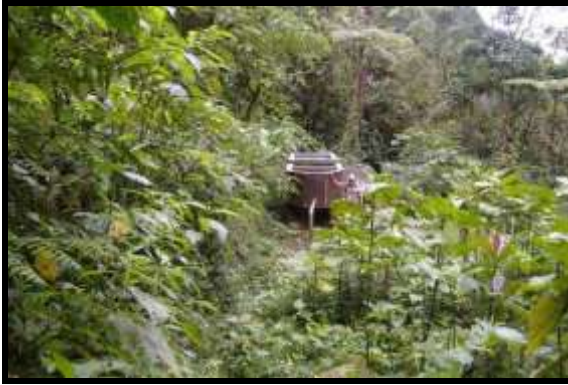
Figura 134 Vista de Tanque desarenador
