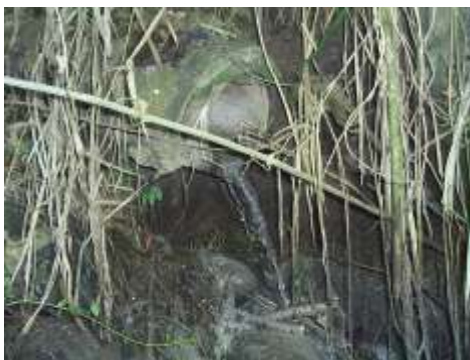
Figura 111 Vertimiento Barrio Chapinero
