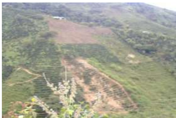
Figura 213 Remoción en masa Vereda La Cañada
