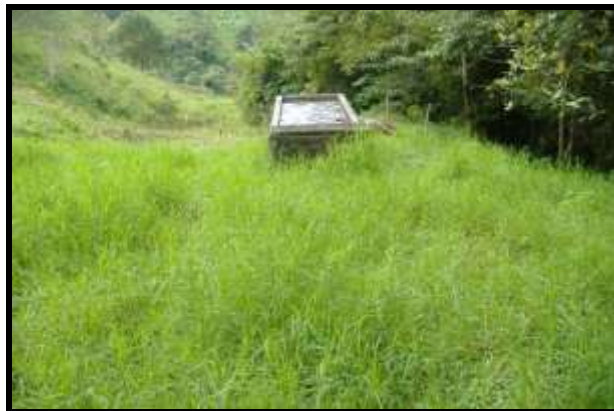
Figura 145 Tanque sedimentador del sistema quebrada Garzón
