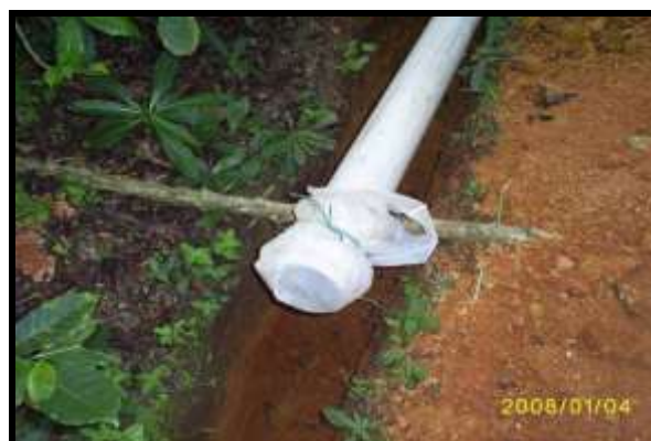
Figura 148 Zanja para acondicionar la Tubería en PVC 4"
