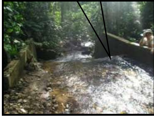
Figura 125 Detalle de muro transversal en la Bocatoma de fondo Quebrada San Benito
