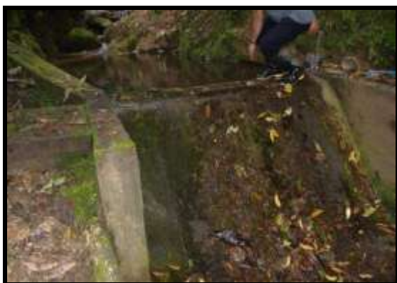
Figura 139 Bocatoma de Fondo Quebrada Paramillo
