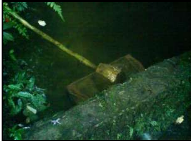
Figura 153 Detalle de filtro en fique Bocatoma artesanal
