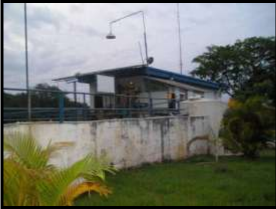
Figura 168 Planta de Tratamiento Acueducto Garzón
