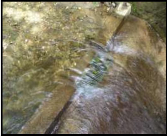
Figura 124 Detalle de rejilla de toma sobre la quebrada San Benito
