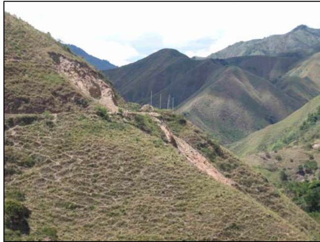
Figura 6.5.4.6. Laderas y cuchillas en rocas graníticas en este sector de Los Cauchos. Obsérvense los desprendimientos asociados con las cortes de la carretera y las terracetos de ganado asociados con el sobrepastoreo en ladera.
