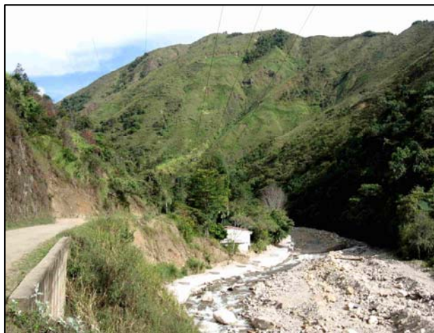
Fig. 6.5.4.1. Vereda Motilón. En la confluencia de la quebrada Motilón con el río Las Ceibas se aprecia un gran aporte de sedimentos proveniente de la erosión tanto del río principal como el afluente. En la foto la escuela abandonado por los peligros de avalancha.
