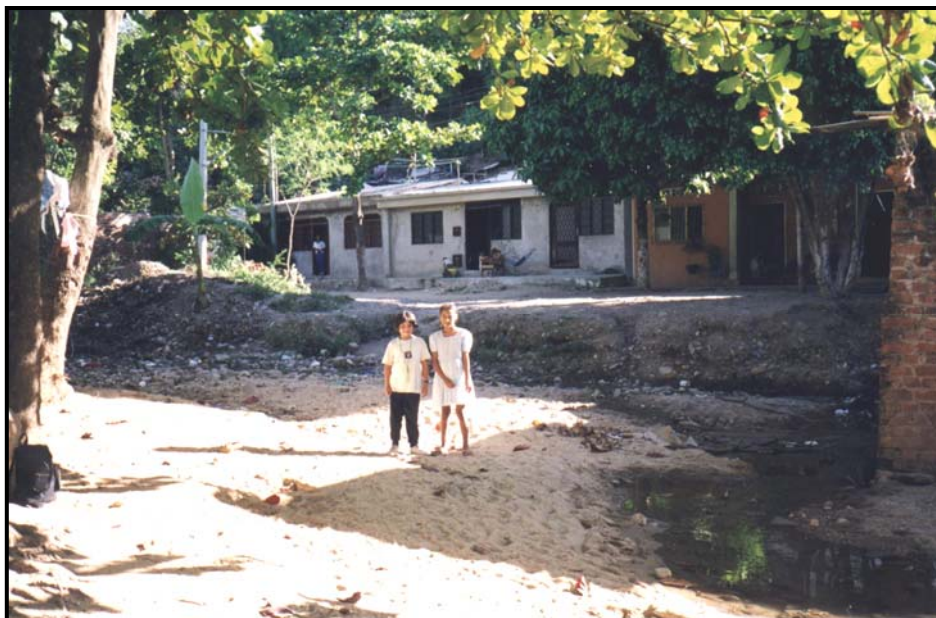
Figura 6.5.4.12. Desviación del cauce de la quebrada La Toma en la CII 11 con la 21, por la construcción de una vivienda sobre su lecho.
