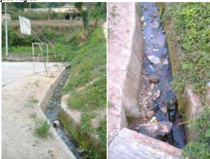
Figura 201. Caño de aguas negras
