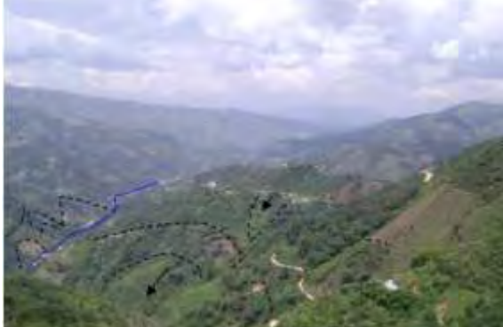
Figura 182. Sector de inestabilidad compleja, en la vereda del Carmen, Arriba de la población de Bruselas
