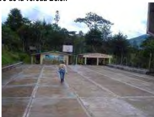
Figura 56. Escuela y polideportivo de la vereda Belén
