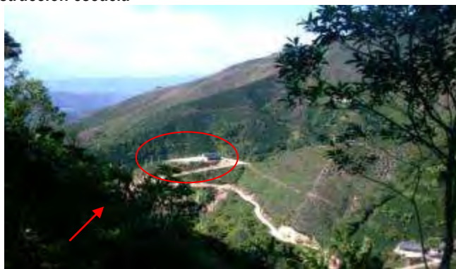
Figura 142. Lugar de construcción escuela
