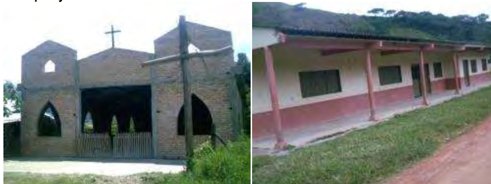
Figura 161. Capilla y Caseta Comunal
