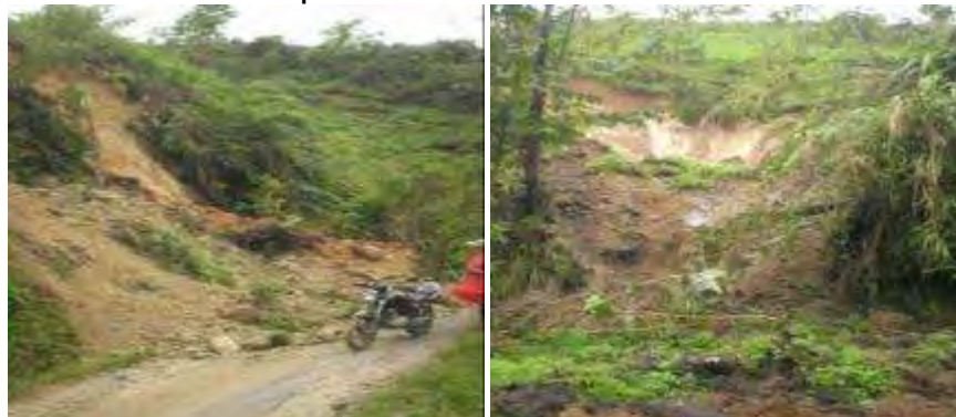
Figura 268. Deslizamientos vereda La Esperanza
