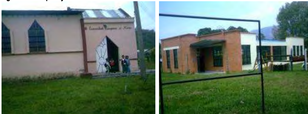
Figura 150. Capilla y Caseta Comunal
