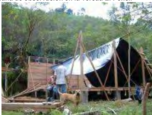
Figura 177. Construcción de cabaña de observación en la vereda El Pensil
