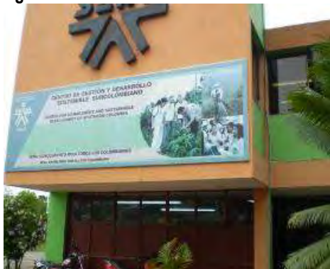
Figura 156. Instalaciones del SENA- Pitalito.
