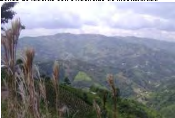
Figura 183. Panorámica del área de la vereda Quebradón, - Parte alta de Palestina donde se observan algunas zonas de laderas con evidencias de inestabilidad
