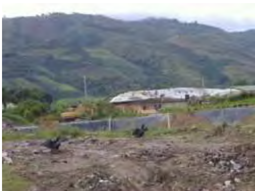
Figura 152. Estado actual de una de las celdas, Planta de tratamiento de materiales sólidos. Municipio de Pitalito, vereda Contador.
