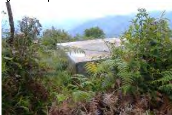
Figura 74. Tanques de almacenamiento
