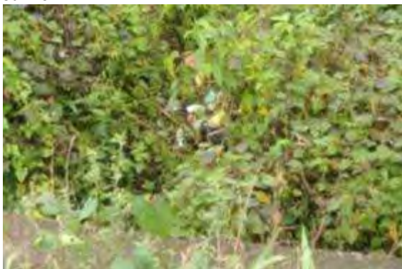
Figura 181. Basuras en alcantarilla de la vereda El Carmen.
