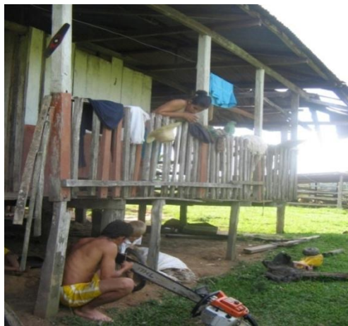
Figura 34. Vivienda rural construida en zancos (palafito), madera, zinc y piso de tabla.
