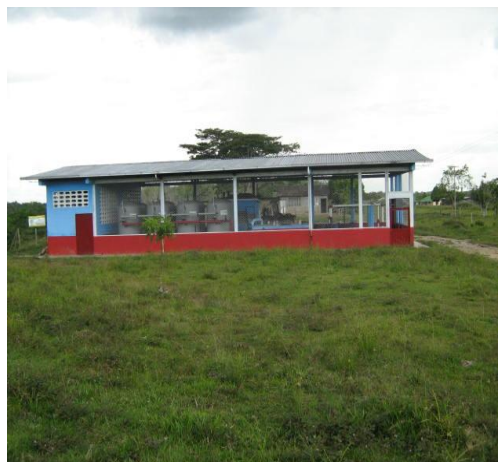
Figura No 37. Planta de tratamiento acueducto Solita
