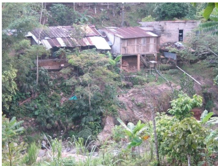
Figura 38: Asentamientos en zonas de riesgo
