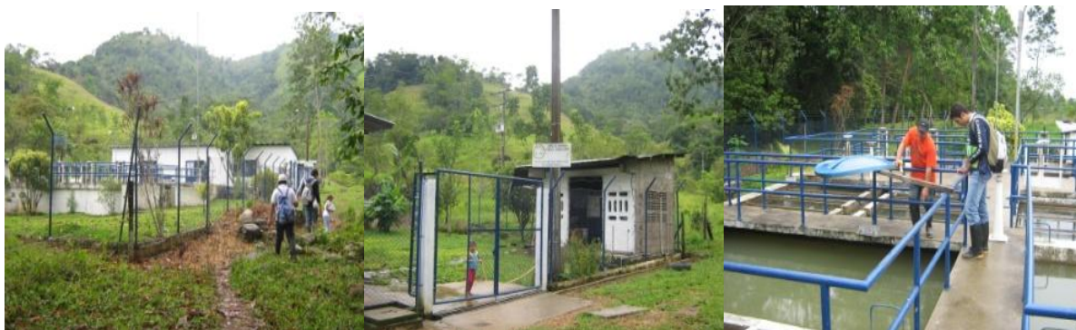
Figura 31: Planta de Tratamiento río El Doncello
