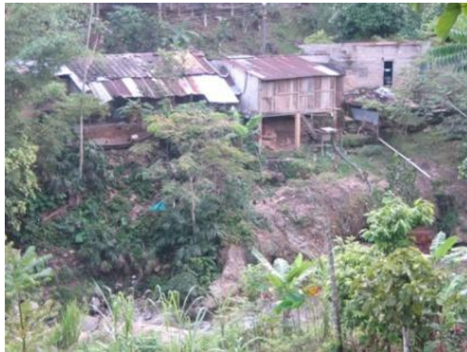
Figura 28: Zona de Riesgo, viviendas cr. 3
