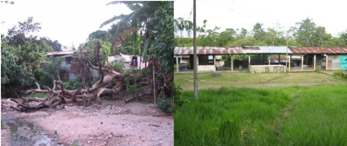
Figura 27: Zona de Riesgo, viviendas aledañas al antiguo matadero
