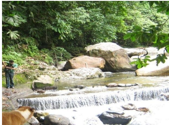
Figura 27: Bocatoma quebrada Las Damas
