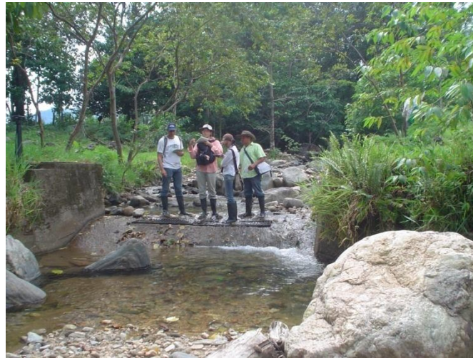
Figura 29: Bocatoma acueducto - Quebrada La Borugo
