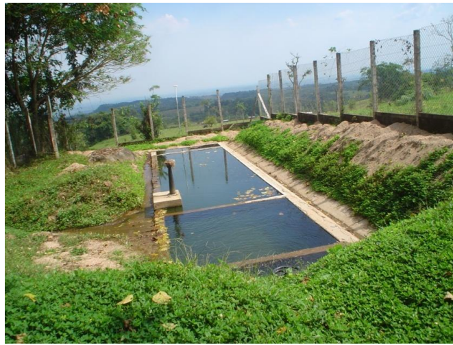
Figura 30: Desarenador quebrada La Borugo
