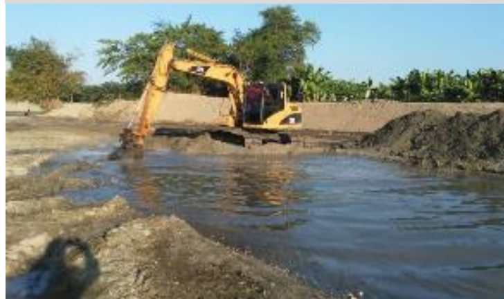
Banco de Maquinaria: Dragado y conformación de dique en el municipio de Zona Bananera
