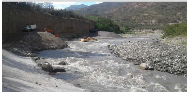
Capitanejo: Construcción de espolones y diques de control
