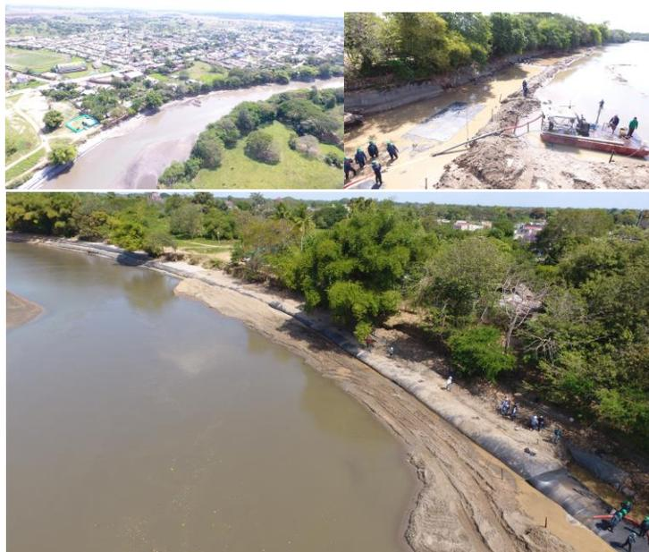
**Yopal, 2 de febrero de 2017. (@UNGRD).** Yopal, 02 de febrero del 2017. La barrera de protección de casi un kilómetro de largo, que se construye en geotubo y geotextil sobre la margen izquierda del río Pauto, frente al casco urbano del municipio de Trinidad, en el departamento de Casanare, presenta un avance de ejecución del 70%.
