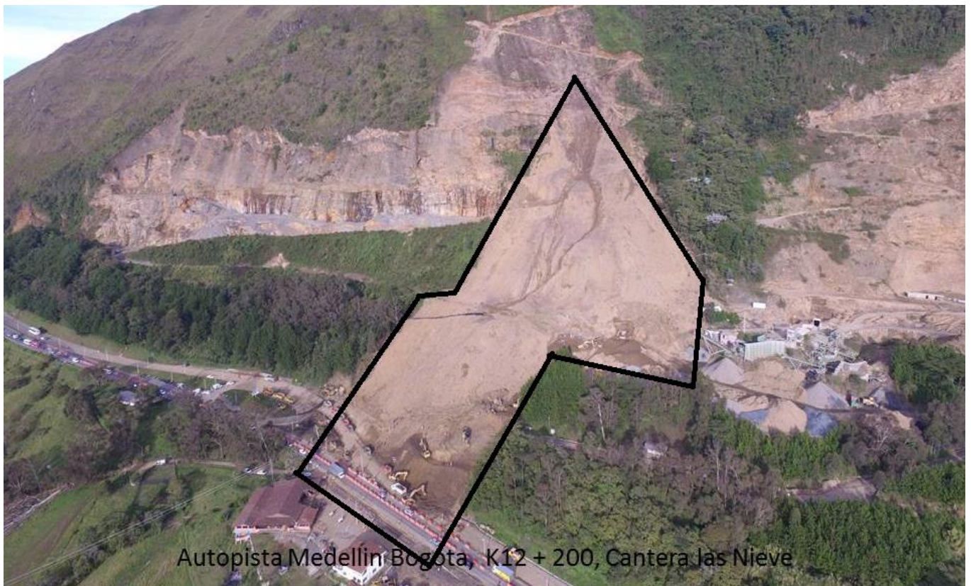
Imagen No 2: Vista del aérea del deslizamiento Fuente Imagen Dron: Juan Camilo Velázquez Tobón - USAR Antioquia
