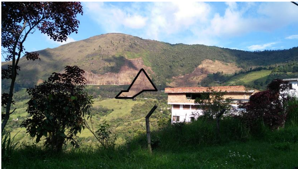
Imagen No 1: Vista del deslizamiento desde la vía Medellín – Bogotá Fuente Imagen: UNGRD
