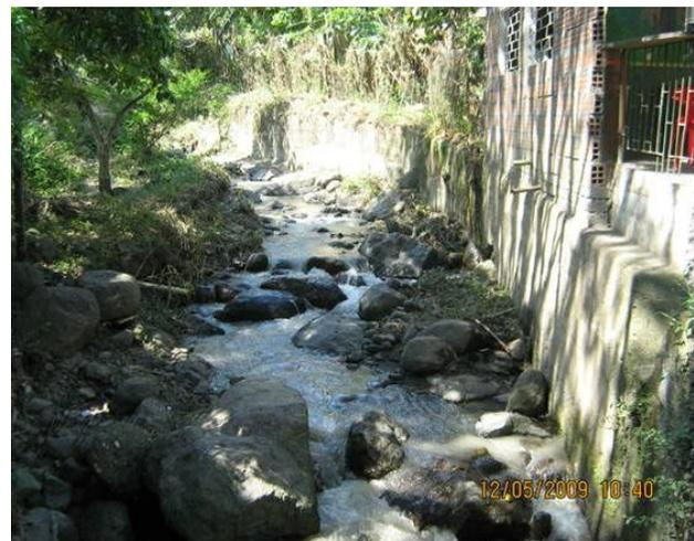
**Figura 3-29. Muros de concreto margen izquierda de la Quebrada La Desmontadora entre Carreras 10 y 11**
