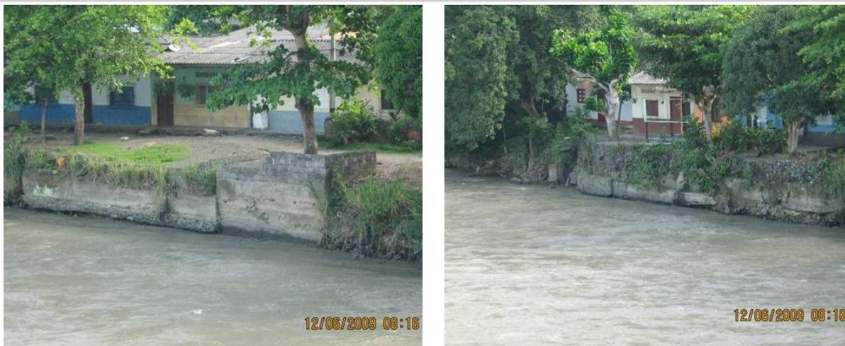
**Figura 3-32. Muros en concreto y gaviones recalzados margen derecha Río Sucio aguas abajo del puente colgante**
