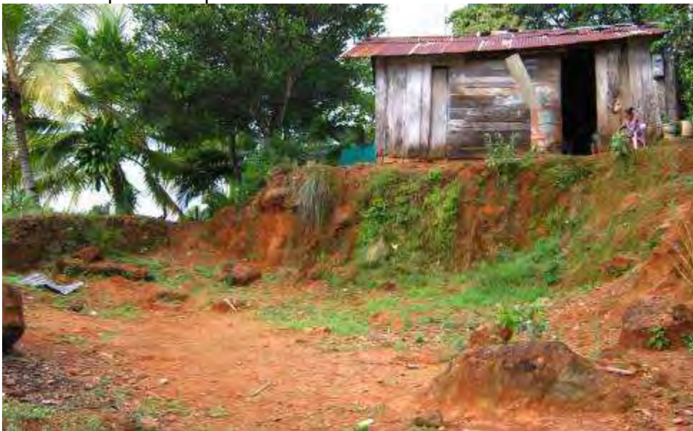
Figura 3- 4 Banqueo para vivienda en La Colina, se observa el suelo tipo C-III, con bloques de roca.
