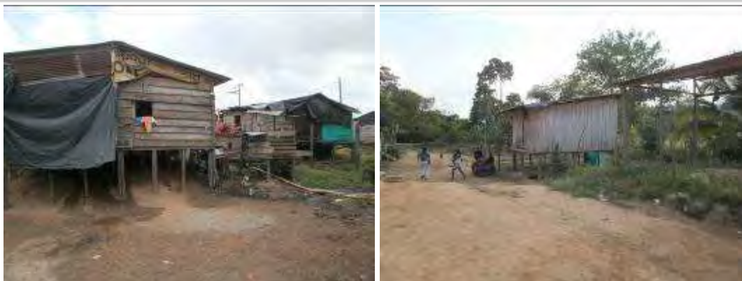
Figura 4- 17 Cimentación de las viviendas cercanas a la margen del rio Bajirá.
