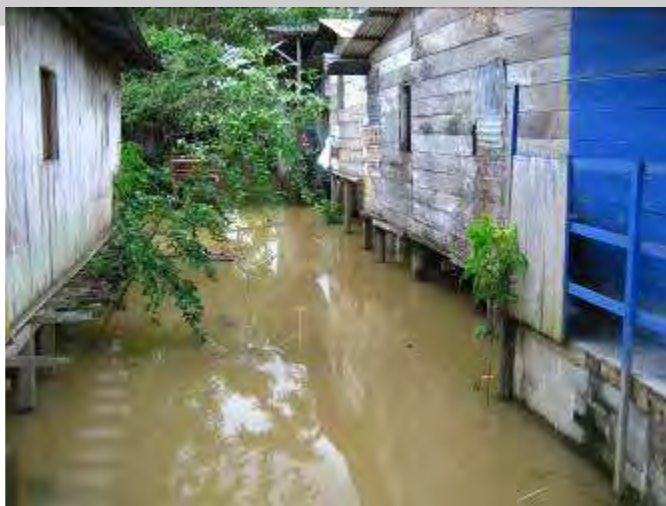
Figura 2- 9 Inundación barrio el centro Fuente: propia
