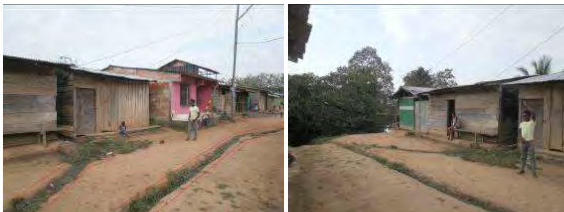
Figura 4- 30 Disposición de aguas servidas por medio de cunetas al Río Bajirá
