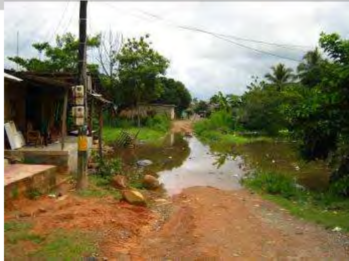
Figura 2- 11 Encharcamiento barrio El Progreso. Fuente: propia
