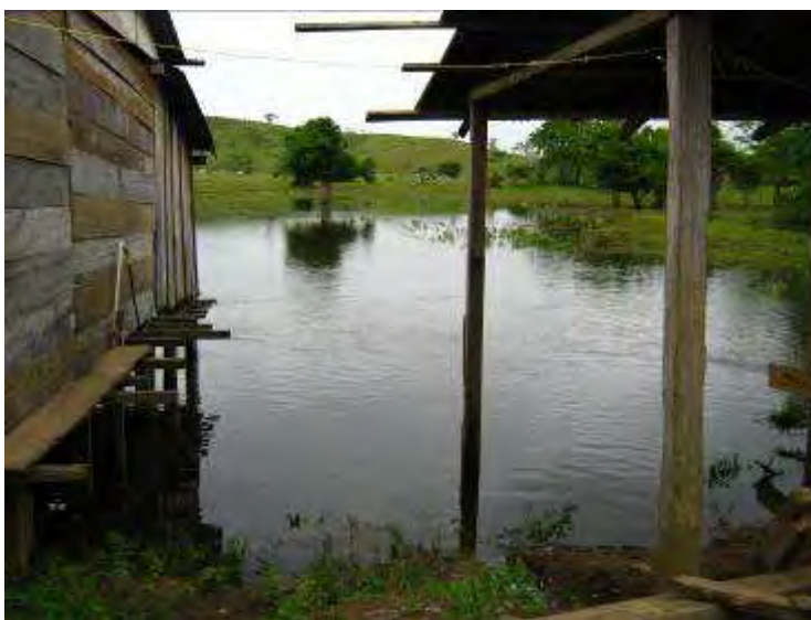
Figura 2- 8 Inundación barrio El indio por caño del mismo nombre. Fuente: propia
