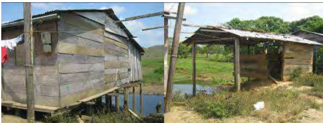
Figura 2- 6 Viviendas sobre Caño el Indio Fuente: propia
