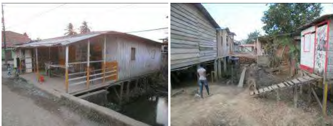
Figura 4- 19 Cimentación de la viviendas en algunos bajos que se presentan en todo el centro poblado. El de la izquierda ubicado en el sector del Centro y el de la derecha en el barrio El Progreso.
