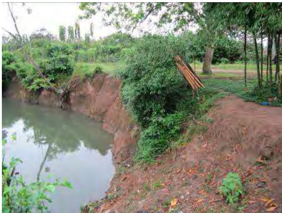
Figura 2- 13 Erosión hídrica unida a intervención de las márgenes Fuente: Propia
