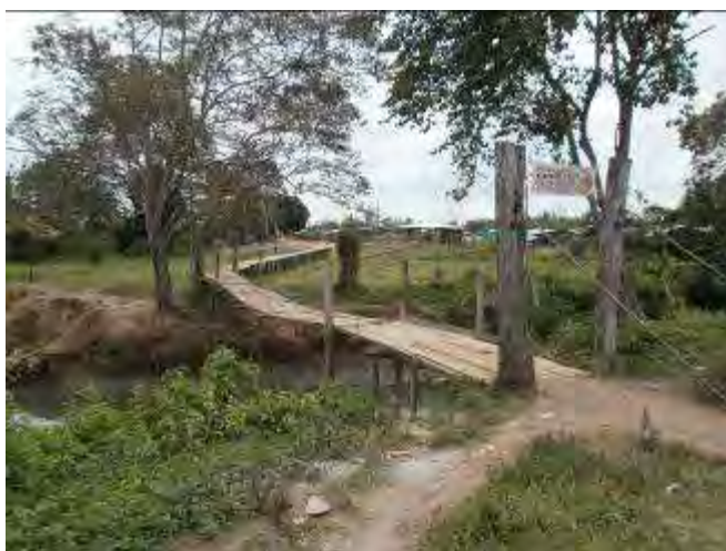
Figura 2- 1 Puente de acceso al Barrio Belencito 2. Época seca. Fuente: propia
