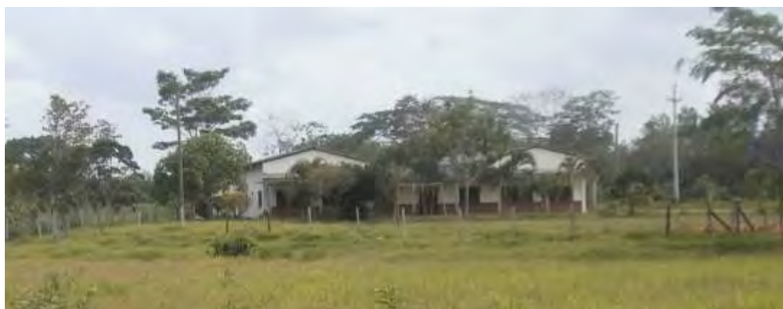
Figura 4- 10 Instalaciones del SENA – Casa Campesina.
