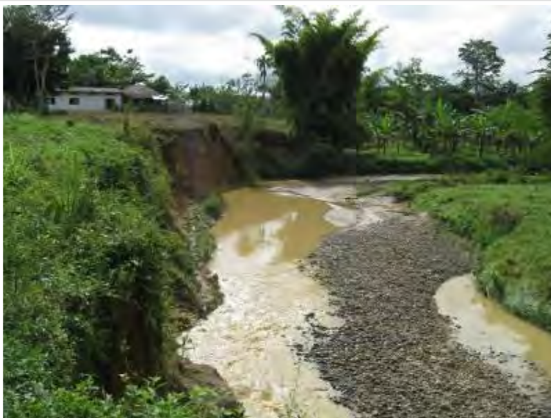
Figura 2- 3 Socavación lateral, Inestabilidad de Márgenes debido al comportamiento sinuoso o meándrico. Fuente: Propia
