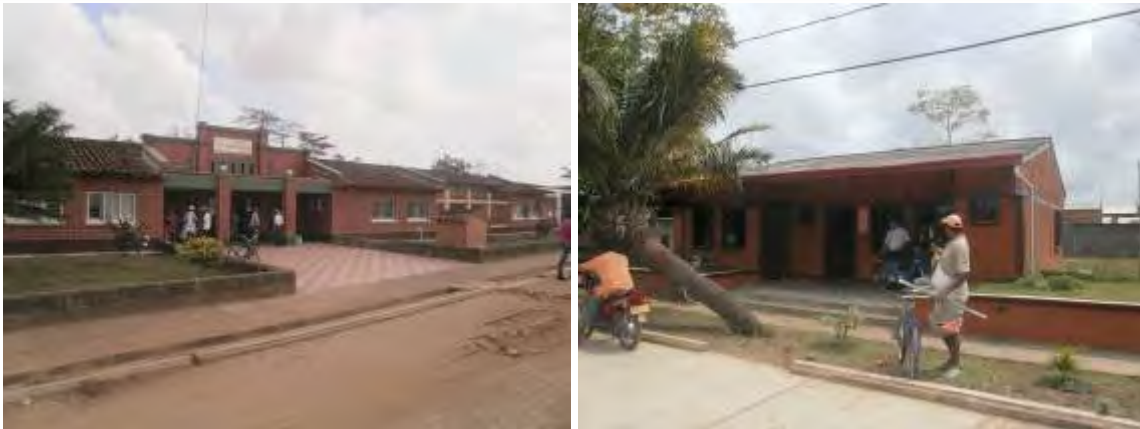
Figura 4- 7 Hospital E.S.E Oscar Emiro Vergara Cruz (izq) y Centro de Salud Barrio 16 de Mayo (der).
