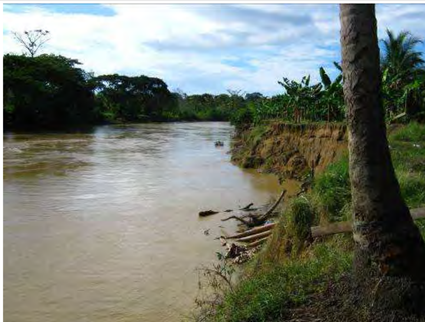
Figura 2- 2 Imágenes del Rio San Juan y el parte del sector San Juan Oriental, donde se han presentado emergencias por inestabilidad de márgenes – socavación lateral.
