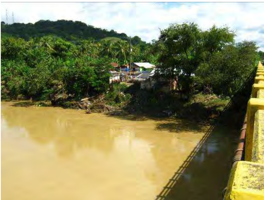
Figura 1- 3 Río San Juan y sector San Juan Oriental, donde se han presentado emergencias por inundación.
