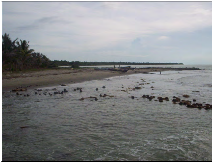
Figura 3.7. Vestigios de obras de protección costera en Damaquiel
