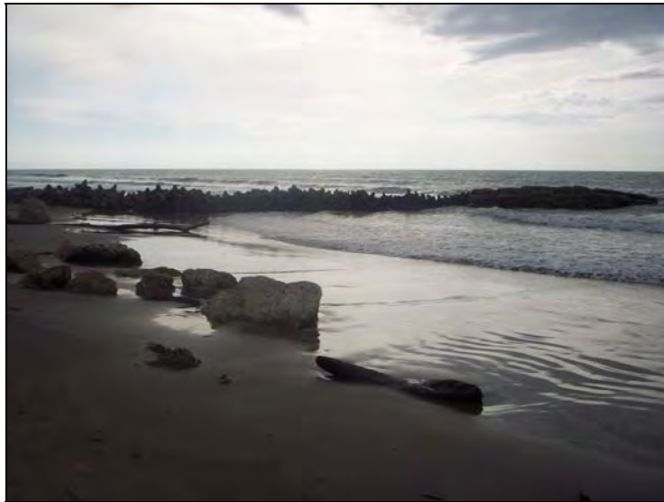
Figura 3.9. Obras de protección costera en Uveros – Espolón 2
