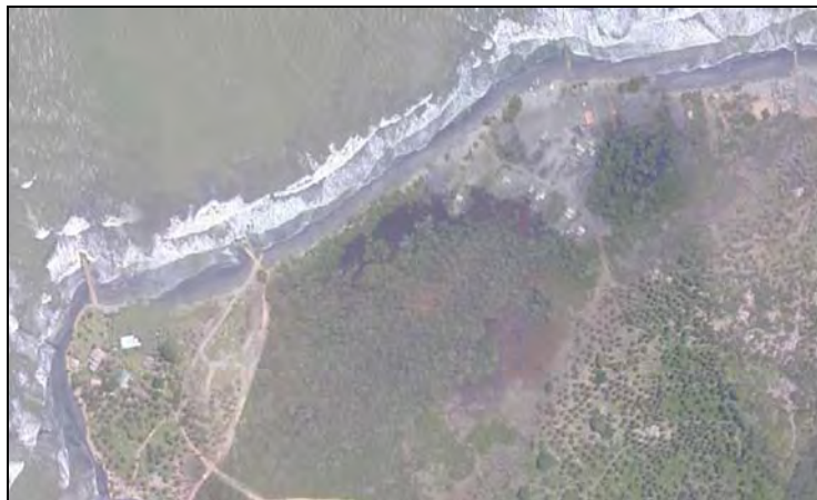
Figura 3.29. Obras de protección costera entre punta Manzanillo y punta de Piedra
