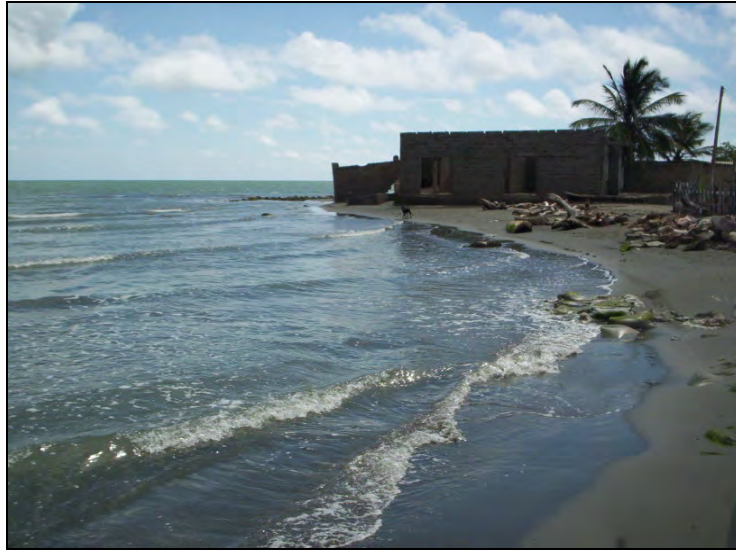
Figura 3.28. Vestigios del intenso proceso de erosión en Punta La Rada
