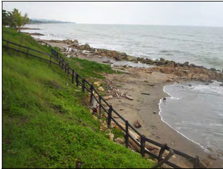
Figura 3.13. Obras de protección costera en Arboletes – Tómbolos
