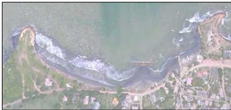
Figura 3.20. Obras de protección costera entre Punta Piedra y Punta Puerto Viejo
