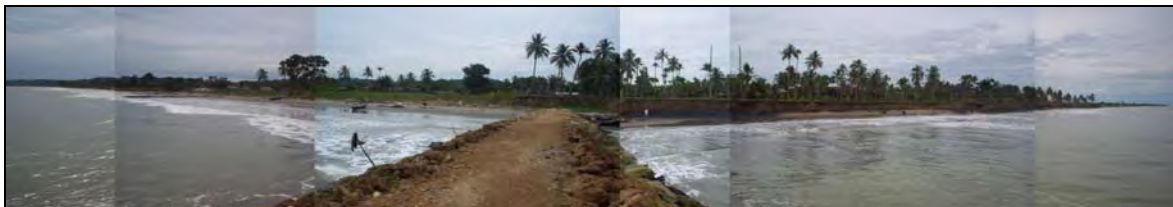
Figura 3.18. Obras de protección costera en Los Córdoba
