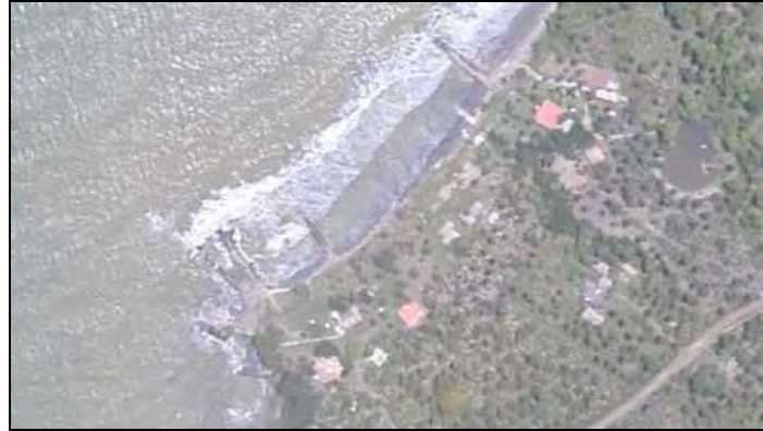
Figura 3.25. Obras de protección costera entre Punta Buenos Aires y Boca Mangle
