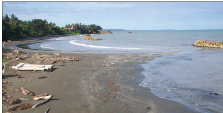
Figura 3.24. Obras de protección costera en Puerto Escondido – Tómbolos
