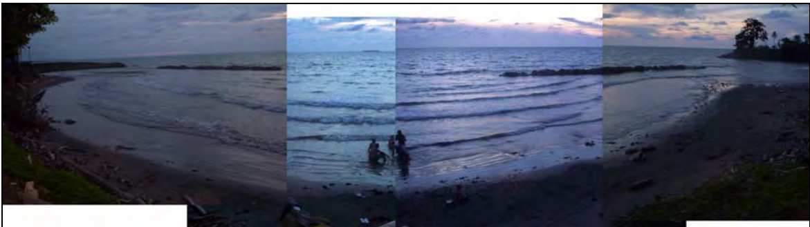
Figura 3.23. Obras de protección costera en Puerto Escondido
