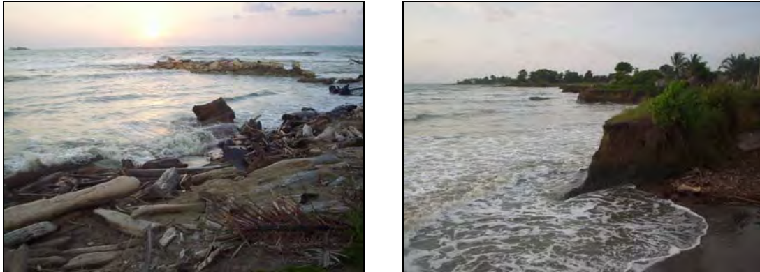
Figura 3.17. Obras de protección costera en Arboletes – Punta Rey
