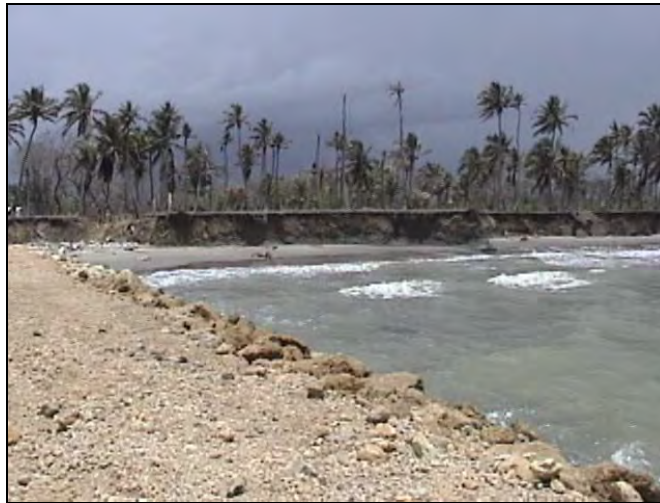
Figura 3.4. Erosión en Los Córdoba
