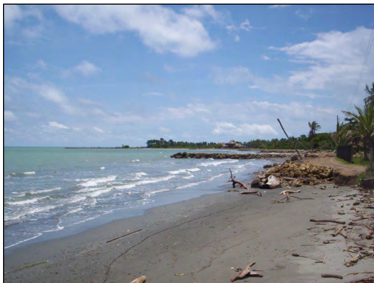
Figura 3.27. Obras de protección costera en Punta El Medio
