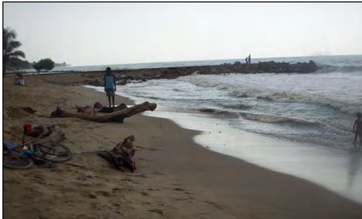
Figura 3.11. Obras de protección costera en Arboletes – Espolón principal
