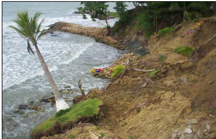
Figura 3.12. Obras de protección costera en Arboletes – Noreste
