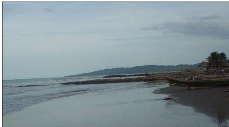
Figura 3.8. Obras de protección costera en Uveros – Espolón 1
