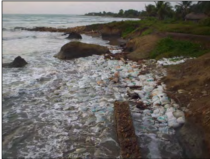
Figura 3.16. Obras de protección costera en Arboletes – Minuto de Dios
