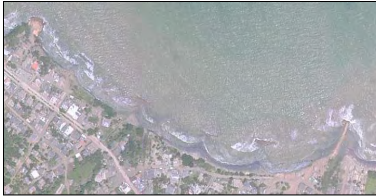
Figura 3.22. Obras de protección costera entre Punta Iguana y Punta Candela
