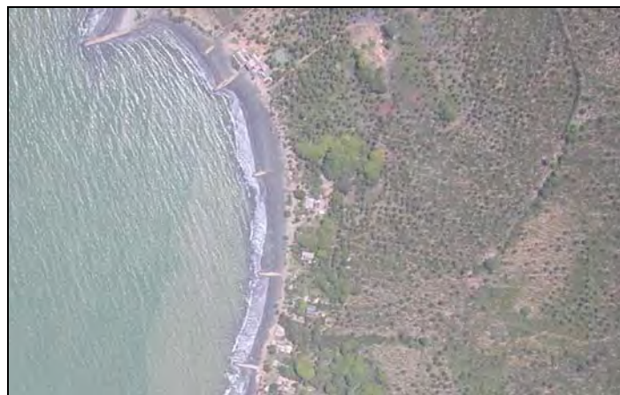
Figura 3.26. Obras de protección costera entre Punta Broqueles y Punta El Medio
