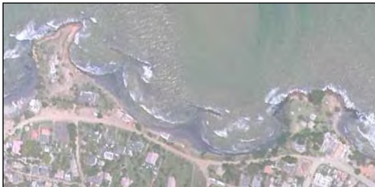
Figura 3.21. Obras de protección costera entre Punta Puerto Viejo y Punta Cangrejo
