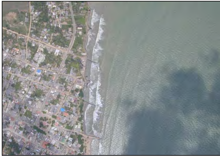
Figura 3.10. Obras de protección costera en Arboletes – Casco urbano
