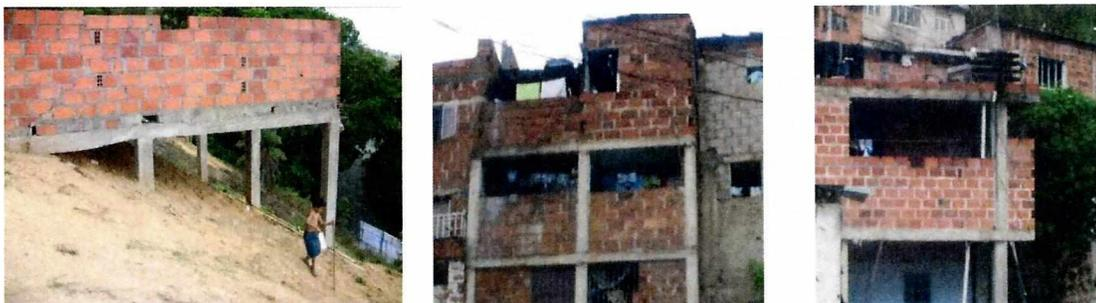
Figura No. 20 Ejemplos presencia de columna Corta
