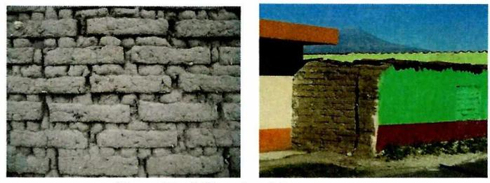
Figura No. 3 Muro de adobe y Sección del muro de adobe de edificación. (Imagen: [www.joseluisluna.com](http://www.joseluisluna.com))
