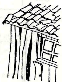
Alabeo y desprendimiento de piezas debido a los cambios de humedad.
