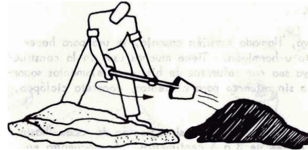
Obrero mezclando el cemento y la arena.
