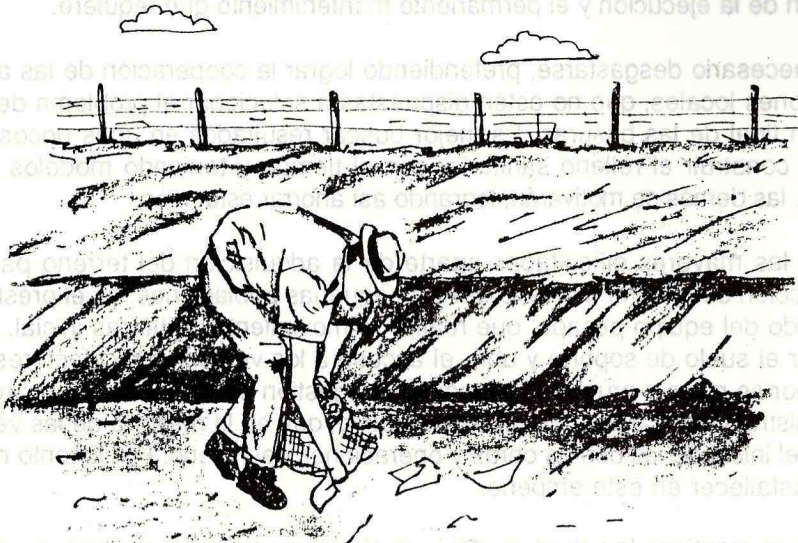
Figura 6.2 Limpieza del área del relleno de materiales dispersos.
