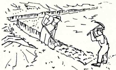
Figura 2.7 Construcción de drenaje periférico.
