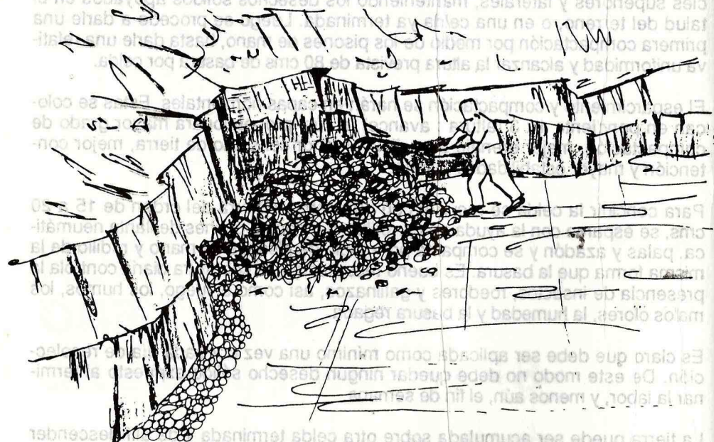
Figura 4.2 Esparcimiento de los desechos en el área limitada para la celda.
