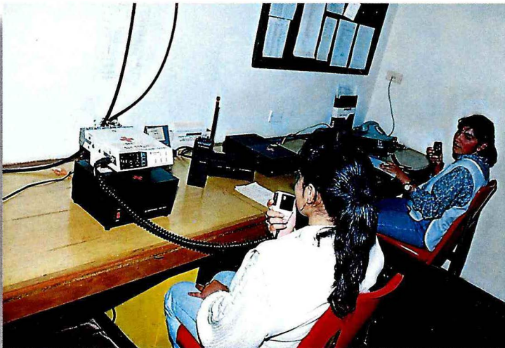
Estación de radio para operativo en emergencia.
