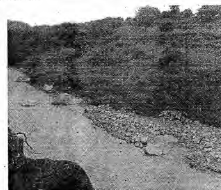
FOTO 4. PARTE BAJA RIO TIMANA CASCO URBANO.
