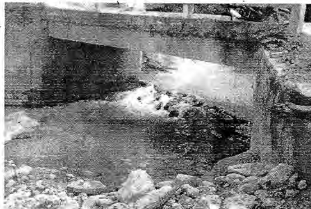
Foto 5. Profundización Cauce Nutria Aguas Abajo Puente Charco R.
