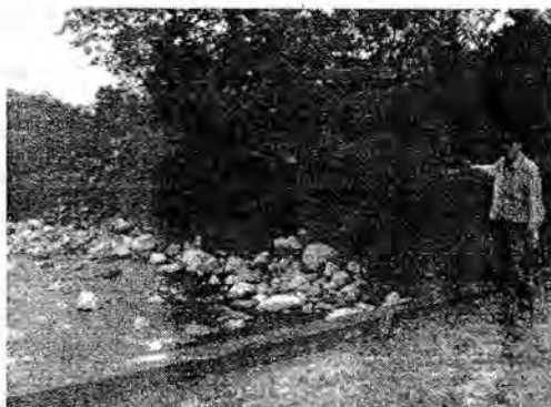
Foto 5. Puente Vereda Tejar Vía Mantagua.
