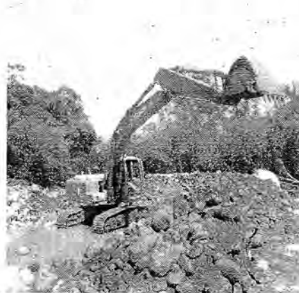
Foto 5. Dragado Cauce Qda la Nutria Aguas Abajo Puente Charco R.
