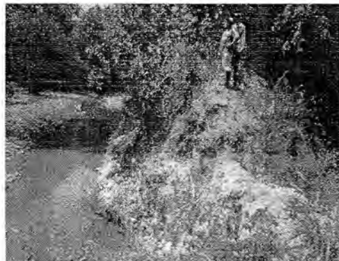
Foto 5. Quebrada la Nutria Canal de Riego Interlagos Tomo 2 Carga Hidraulica Costado derecho del cauce aguas abajo, socavando canal.
