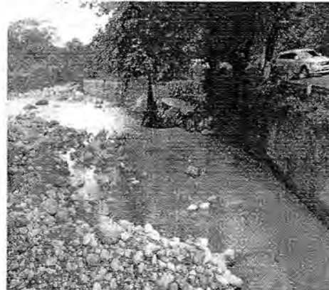
Foto 8. Al fondo Muro Destruido Por la Avalancha Qda Nutria, via Baraya-Colombia, Aguas Abajo Puente Charco Redondo
