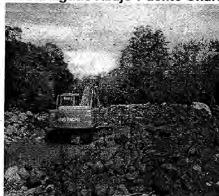
Foto 4. Dragado Cauce Qda la Nutria Aguas Abajo Puente Charco R
