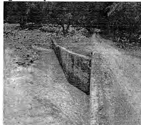
Foto 10. Protección Vía Veredas Saleros. Río Blanco Sector Aguas Arriba Puente CH. R
