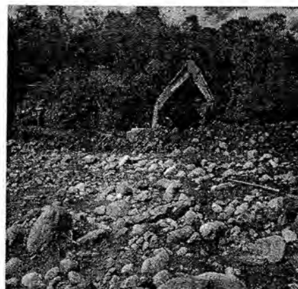
Foto 6. Dragado Cauce Qda la Nutria Aguas Abajo Puente Charco R
