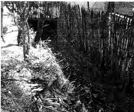
FOTO 1. LOCALIZACION CANAL 2 AGUAS ARRIBA BARRIO PUEBLO NUEVO MPIO BARAYA-HUILA.
