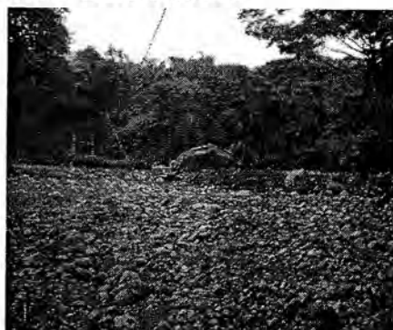
Foto 2. Dragado Cauce Qda la Nutria Aguas Abajo Puente Charco R.
