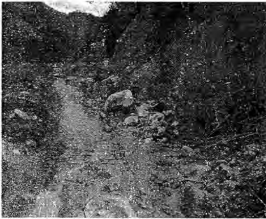
FOTO1. ESTADO DE LA VIA A 2KM DE LA OBRA VEREDA PICUMA MPIO SUAZ
