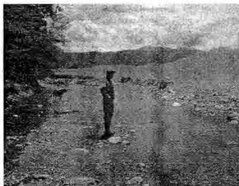
Foto 11. Dragado Cauce Qda Guaroco. Finca Manila.
