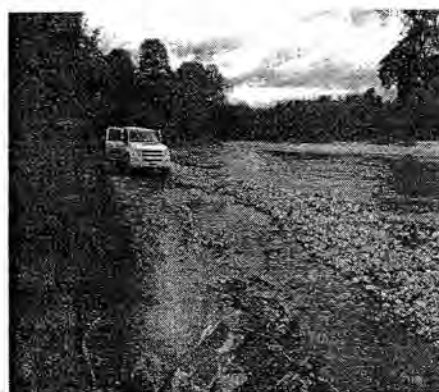
FOTO 10. ESTADO DE LA VIA CIENAGA EL RINCON
