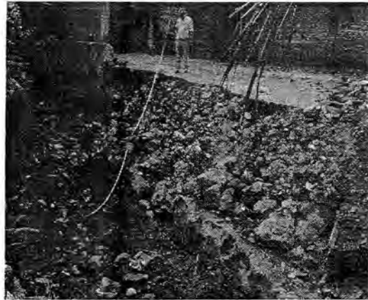
FOTO 2. LOCALIZACION CANAL AGUAS ABAJO BARRIO PUEBLO NUEVO MPIO BARAYA-HUILA
