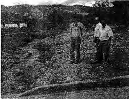
FOTO1. LOCALIZACIÓN CON EL MUNICIPIO DRAGADO QUEBRADA EL MOSCA.
