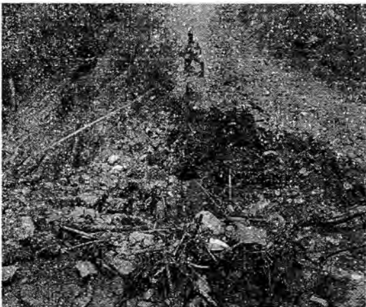
FOTO5. LOCALIZACION BOX COULVERT VEREDA PICUMA MPIO SUAZ
