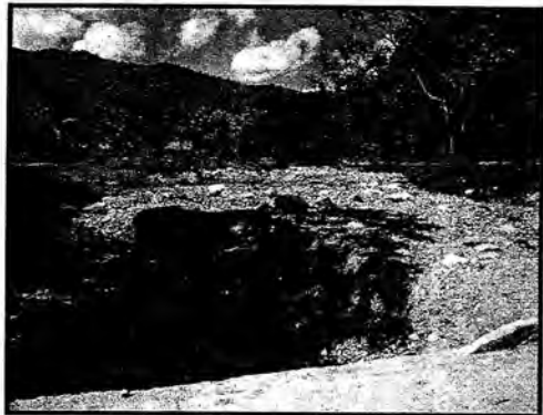
FOTO 1. SECCION HIDRAULICA QUEBRADA EL MOSCA AGUAS ARRIBA PUENTE B. EL MOSCA
