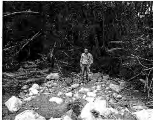
FOTO 2. LOCALIZACION MURO GAVION AGUAS ABAJO
