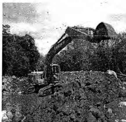
Foto 5. Dragado Cauce Qda la Nutria Aguas Abajo Puente Charco R.
