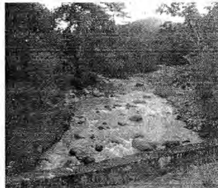
FOTO 2. PUENTE AGUAS ARRIBA RIO TIMANA.
