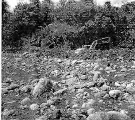
Foto 7. Dragado Cauce Qda la Nutria Aguas Abajo Puente Charco R.
