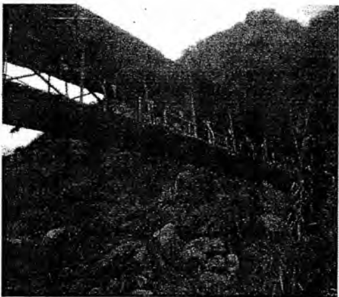
Foto 11. Puente Peatonal Vereda La Ensillada Sector Bajo, Descarga Río Quebradón Sur-Río Blanco.
