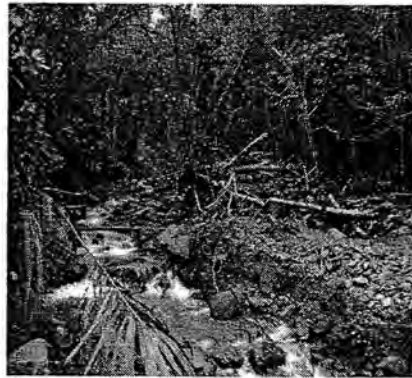
Foto 7. Afectación Vía Cruce Vdas Juntas-Jordán.
