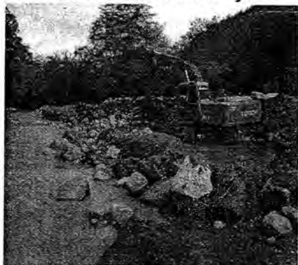
Foto 3. Dragado Cauce Qda la Nutria Aguas Abajo Puente Charco R.
