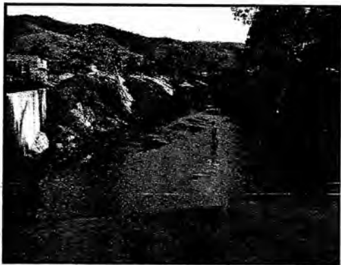
FOTO 3. QUEBRADA EL MOSCA AGUAS ARRIBA PUENTE, CON DRAGADO.
