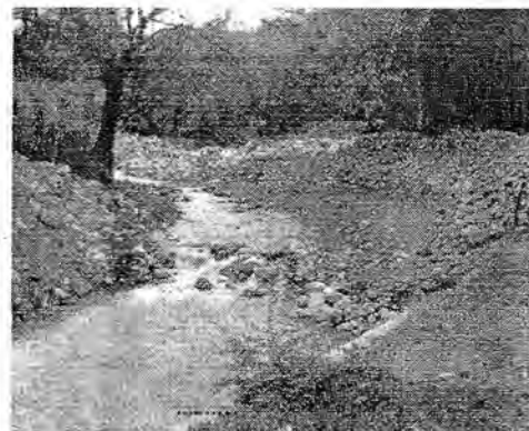
Foto 4. Profundización Cauce Qda la Nutria Aguas Abajo Puente Charco R.
