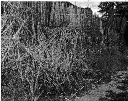
FOTO1. LOCALIZACION MURO GAVION BARRIO AMAPOLITA MPIO HOBO
