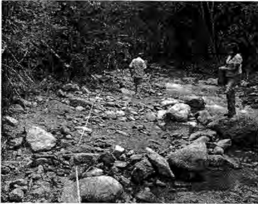
FOTO 1. LOCALIZACION MURO GAVION AGUAS ARRIBA
