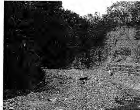
Foto 2. Dique en material aluvial que ha soportado las crecientes o avalanchas.
