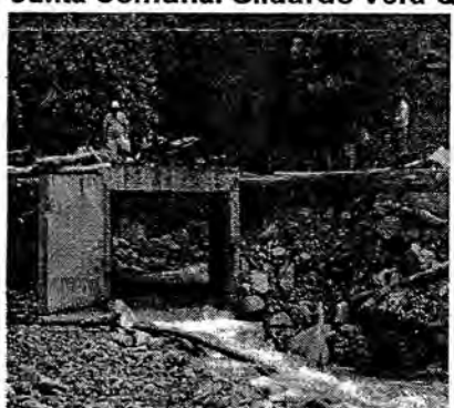
Foto 4. Box-Coulvert Paso Qda Doña Sixta.
