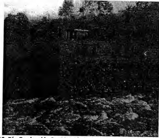
Foto 12. Río Quebradón Sur Vereda La Vereda Santa Lucia, vivienda en alto riesgo.
