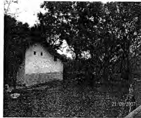
Foto 8. Al fondo Alberca presenta Filtraciones.
