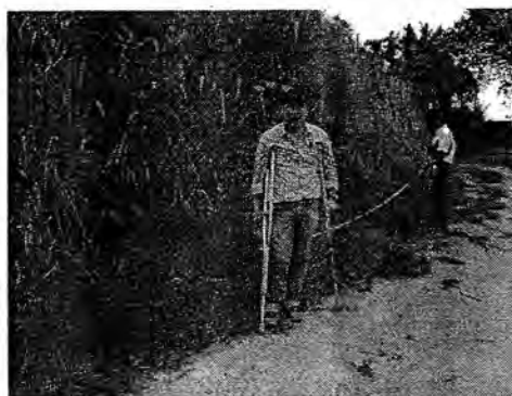
FOTO 4. AL FONDO TOMANDO LA LONGITUD DEL MURO EN GAVION BARRIO AMAPOLITA.
