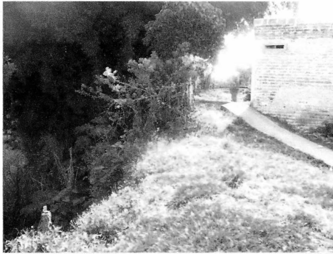
BARRIO EL PROGRESO I – TALUD VIA PAVIMENTADA AL BRILLANTE (FOTO 1)
