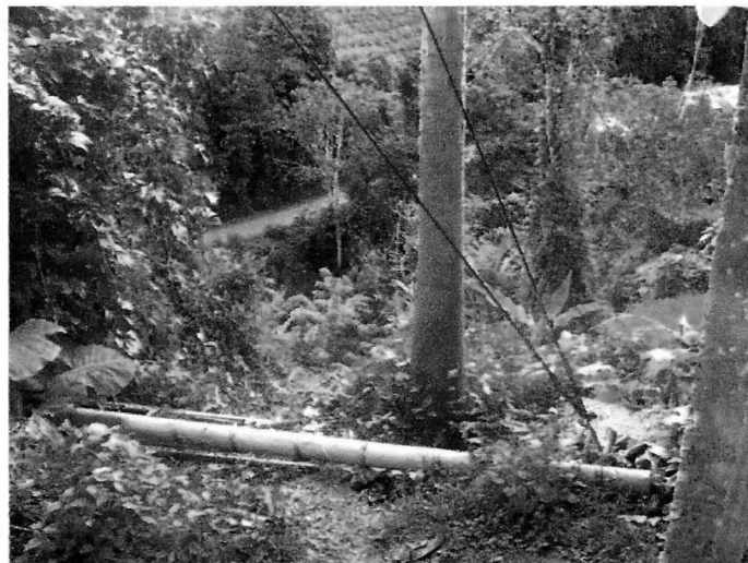
VISTA DETRÁS DE TELECOM SOBRE TALUD VIA EL BRILLANTE (FOTO 2)
