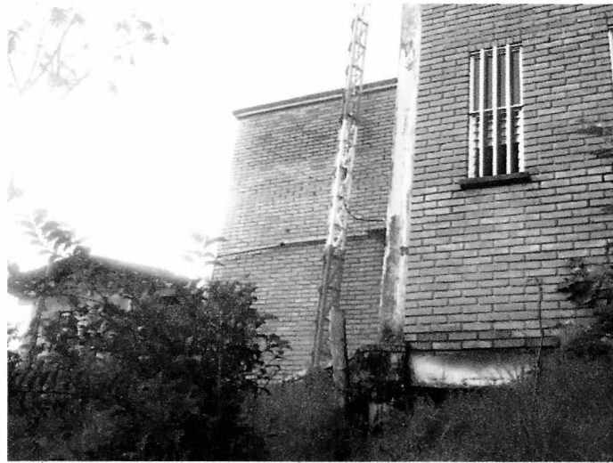
VISTA TRASERA EDIFICIO DE TELECOM (FOTO 1)
