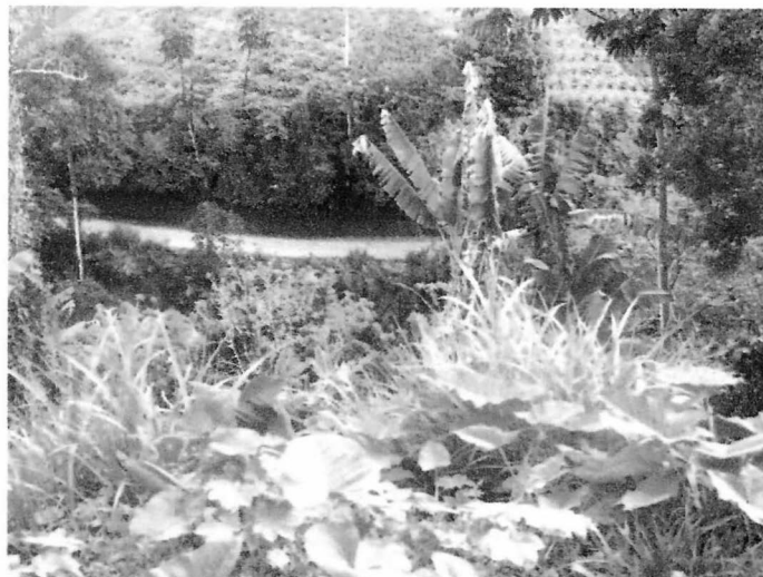
AL LADO DE LA ALCALDIA TALUD CONTRA LA VIA AL BRILLANTE (FOTO 2)
