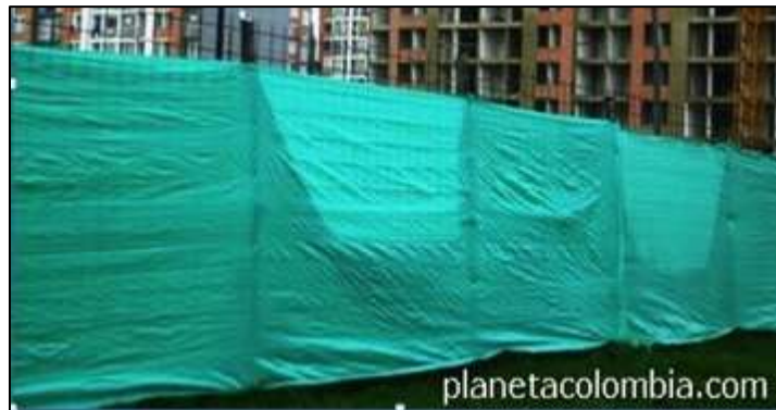
Fotografía 2-9 Cerramiento típico en tela de polipropileno
