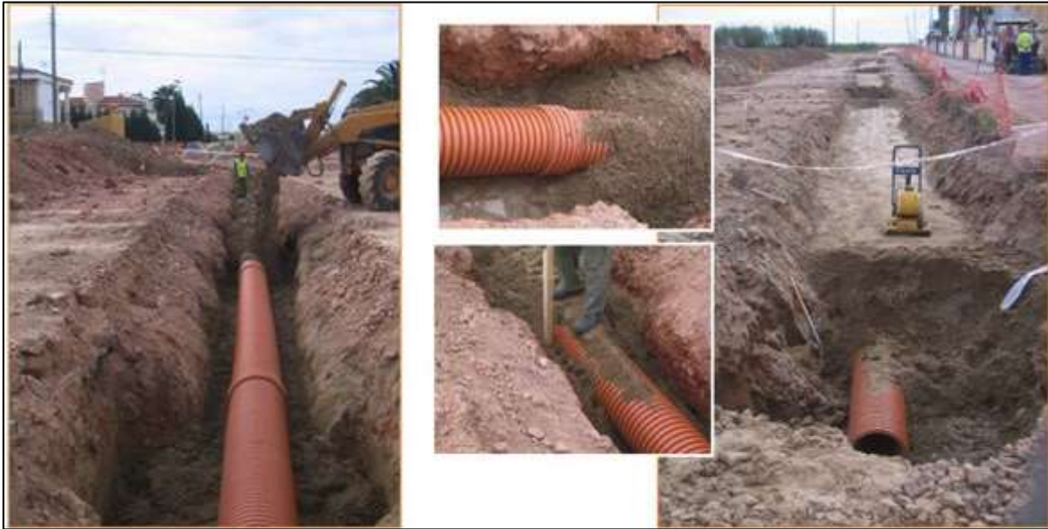
Fotografía 2-12 Relleno zanja para tubería
