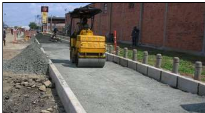
Fotografía 2-18 Instalación de base para adoquín en andén
