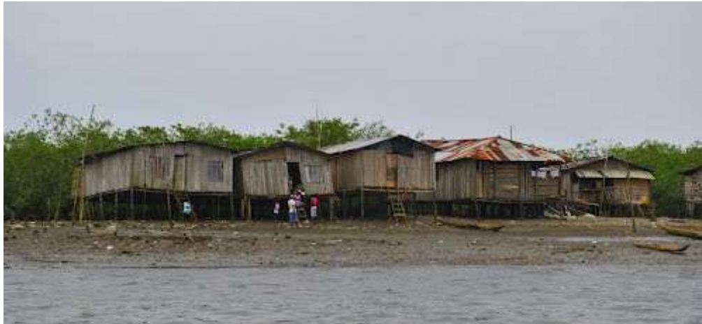
Fotografía 3-1 Viviendas palafíticas típicas en Tumaco
