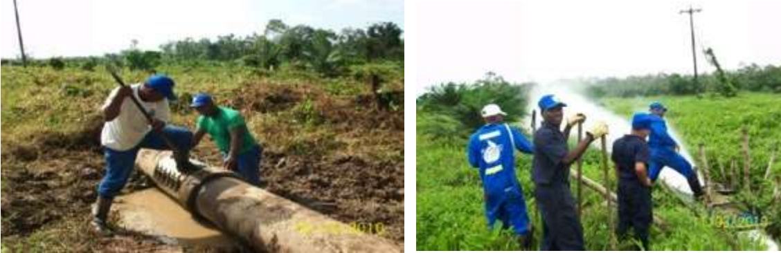
Fotografía 2-2 Reparaciones de tubería de aducción
