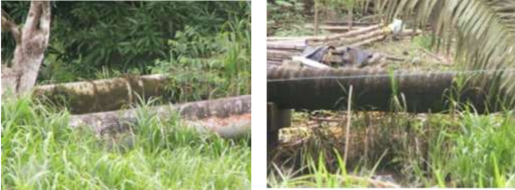
Fotografía 2-1 Estado actual aducción
