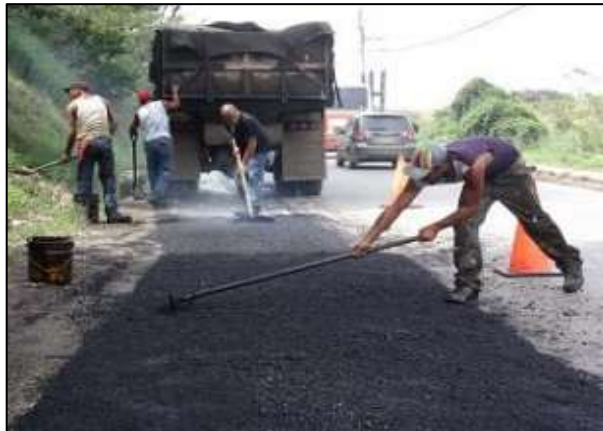
Fotografía 2-17 Instalación de asfalto
