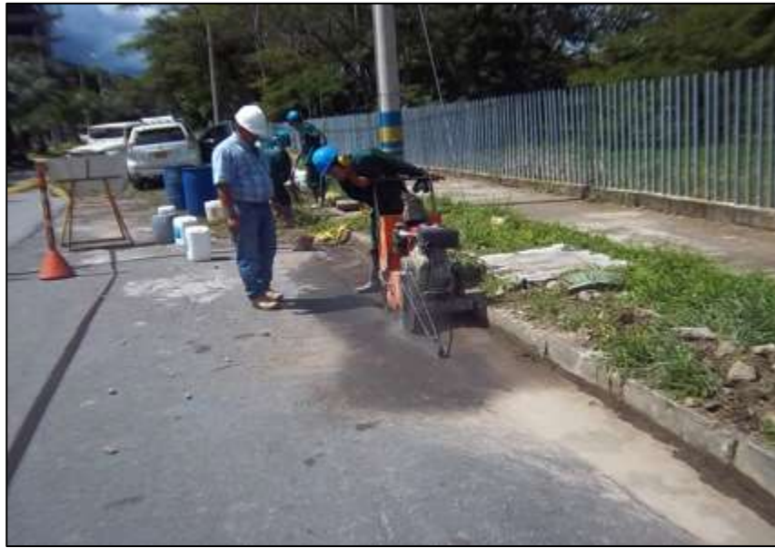
Fotografía 2-16 Corte de pavimento
