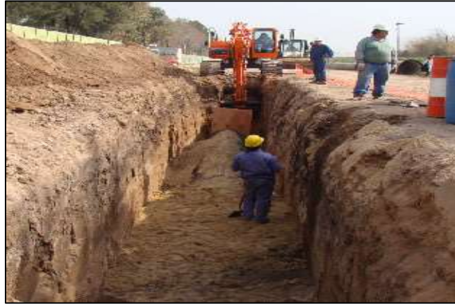
Fotografía 2-7 Excavación para acueducto
