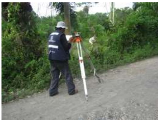
Fotografía 2-6 Topografía para la localización y replanteo
