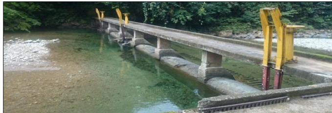
Fotografía 1-7 Canal de Aducción Bocatoma – Desarenador
