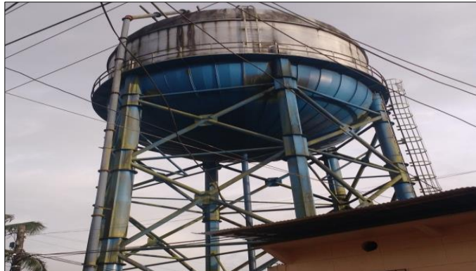
Fotografía 1-22 Tanque de Almacenamiento Nayita
