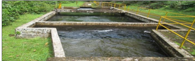
Fotografía 1-9 Desarenador 2 (nuevo)
