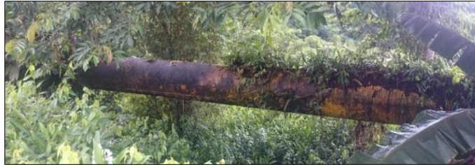
Fotografía 1-18 Tubería 16" paso elevado
