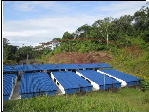
Fotografía 3-36 Zona de ampliación tanque de almacenamiento
