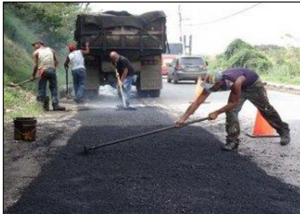
Fotografía 2-17 Instalación de asfalto
