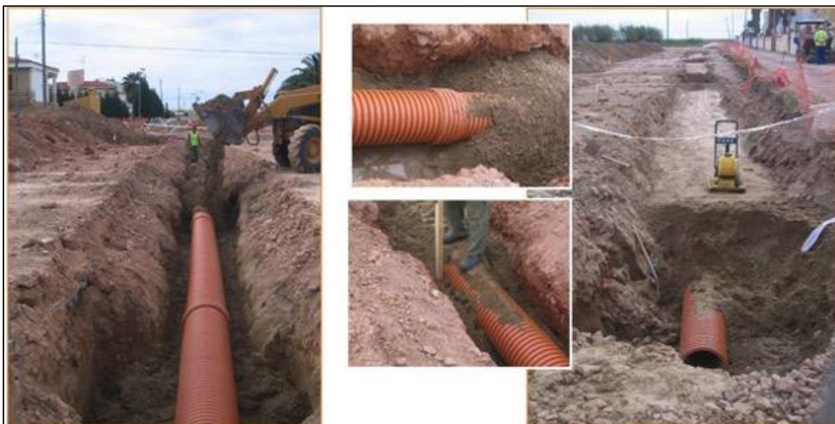
Fotografía 2-12 Relleno zanja para tubería
