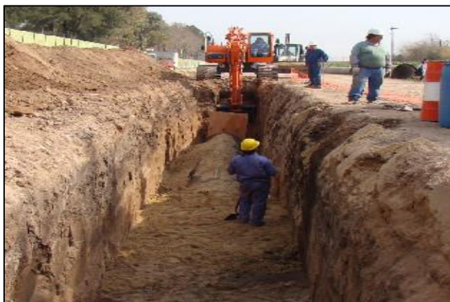
Fotografía 2-7 Excavación para acueducto
