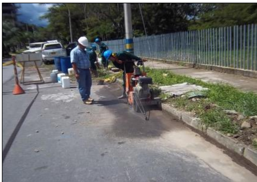
Fotografía 2-16 Corte de pavimento
