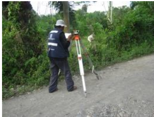
Fotografía 2-6 Topografía para la localización y replanteo
