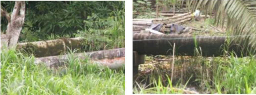
Fotografía 2-1 Estado actual aducción
