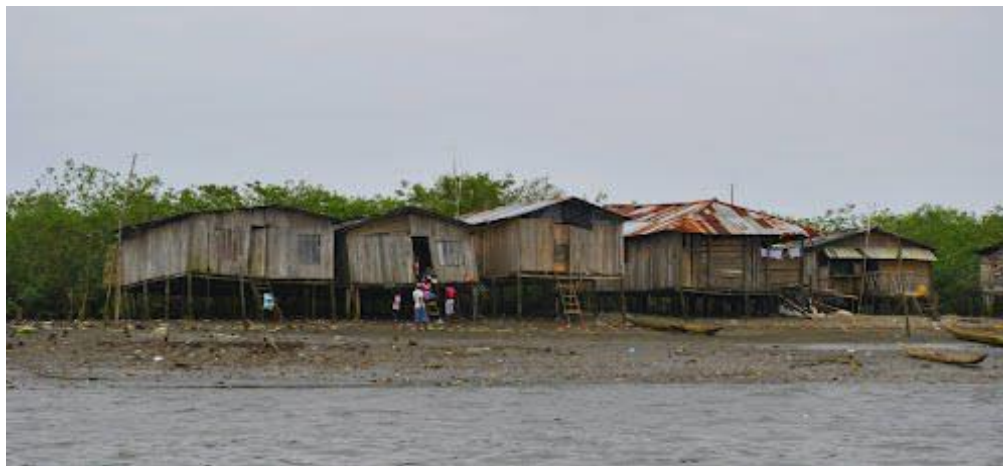
Fotografía 3-1 Viviendas palafíticas típicas en Tumaco
