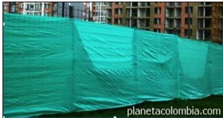
Fotografía 2-9 Cerramiento típico en tela de polipropileno
