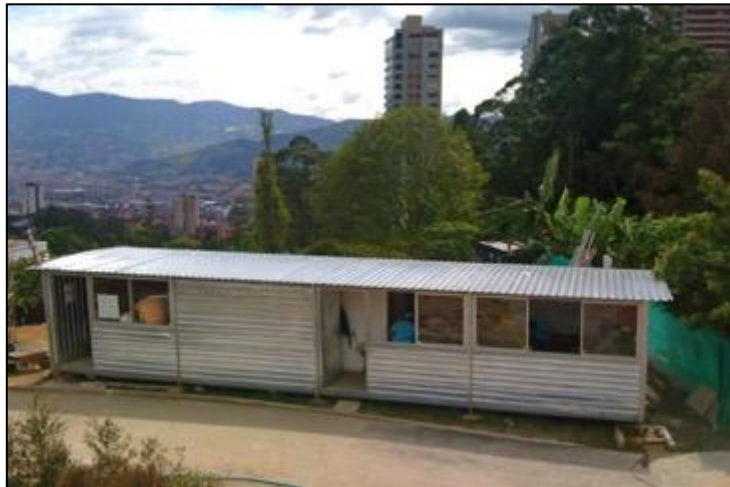
Fotografía 2-4 Campamento en teja de zinc provisional para obra
