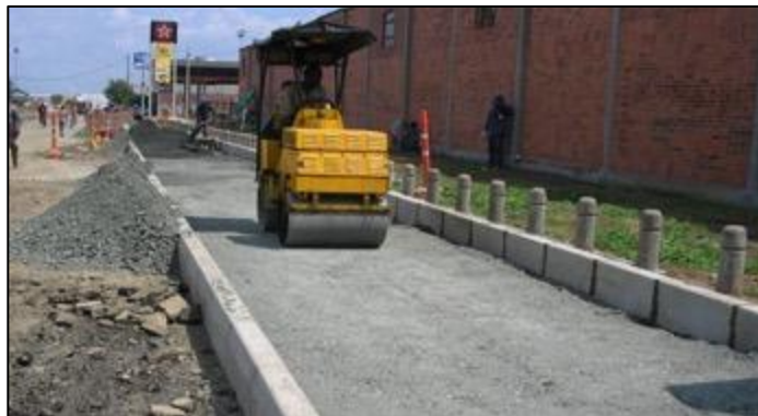
Fotografía 2-18 Instalación de base para adoquín en andén
