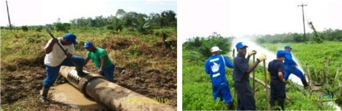
Fotografía 2-2 Reparaciones de tubería de aducción
