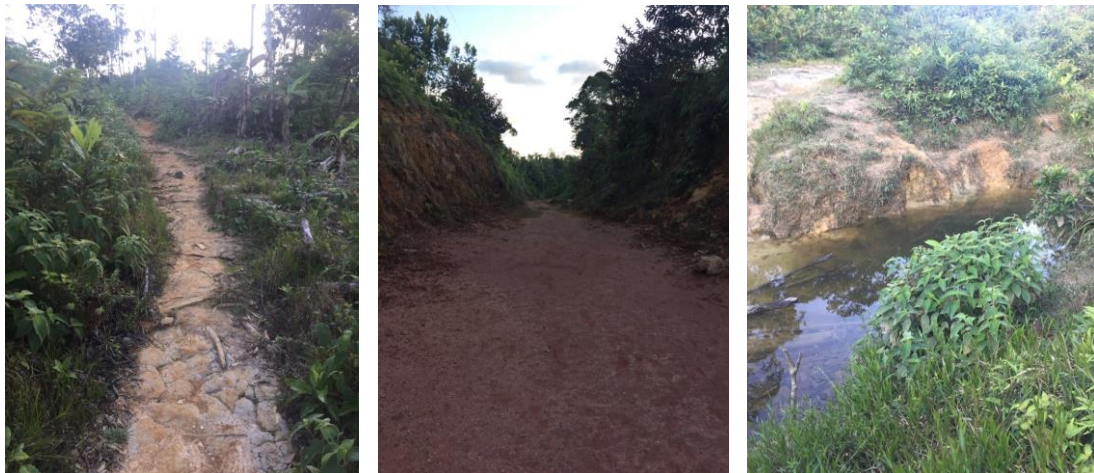
Fotografía 3-3 Vía existente entre la cabecera urbana de Timbiquí y corregimiento de Bubuey
