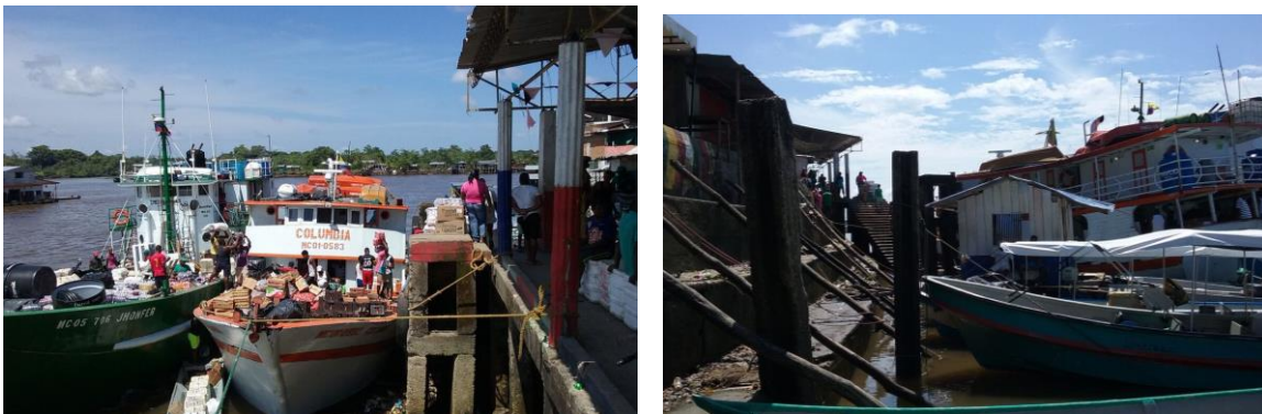
Fotografía 3-4 Muelle actual de El Charco
